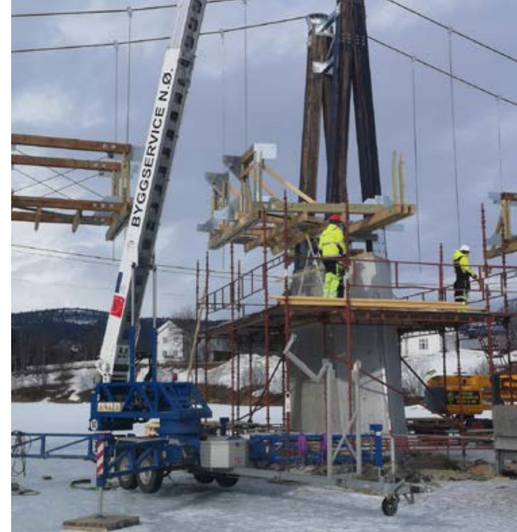
I løpet av noen få uker i mars ble hele brua reist på isen. Her blir en av de to balkongene montert. (Foto: Ola Grønn-Hagen).
