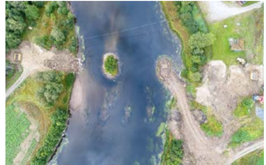
På dette bildet tatt med drone, ser vi tydelig de to øyene med brukar etter forrige bru på Neby. Her er det også lagd vei ut til den første av de to øyene for å starte arbeidet med støping. Det er lett å se sporene i elva etter tidligere bruer på Neby. (Foto: Tor Inge Snekkemoen.)
