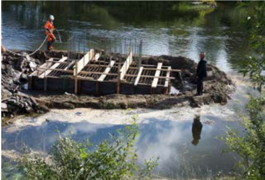
Det første brukaret støpes, og Ola Grønn-Hagen følger spent med på arbeidet. (Foto: Egil Scott Synnestevedt)
