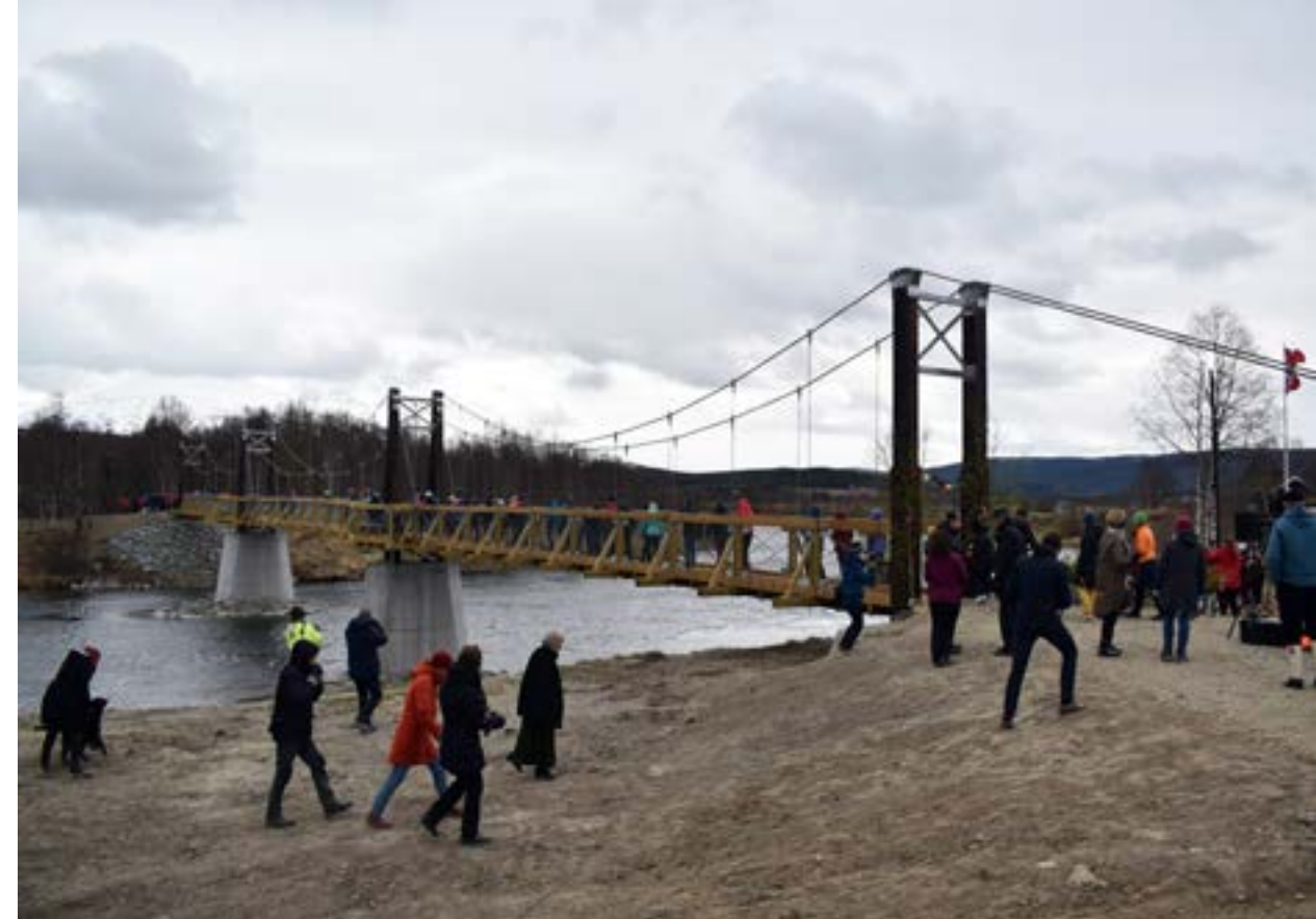
Mange møtte opp men strenge koronarestriksjoner førte til at langt flere fulgte åpningsseremonien for nye Neby bru direkte på nett 16. mai 2020. Ordfører i Tynset, Merete Myhre Moen, kom pr råbåt til åpningsseremonien. (Foto: Harald Sletten)
