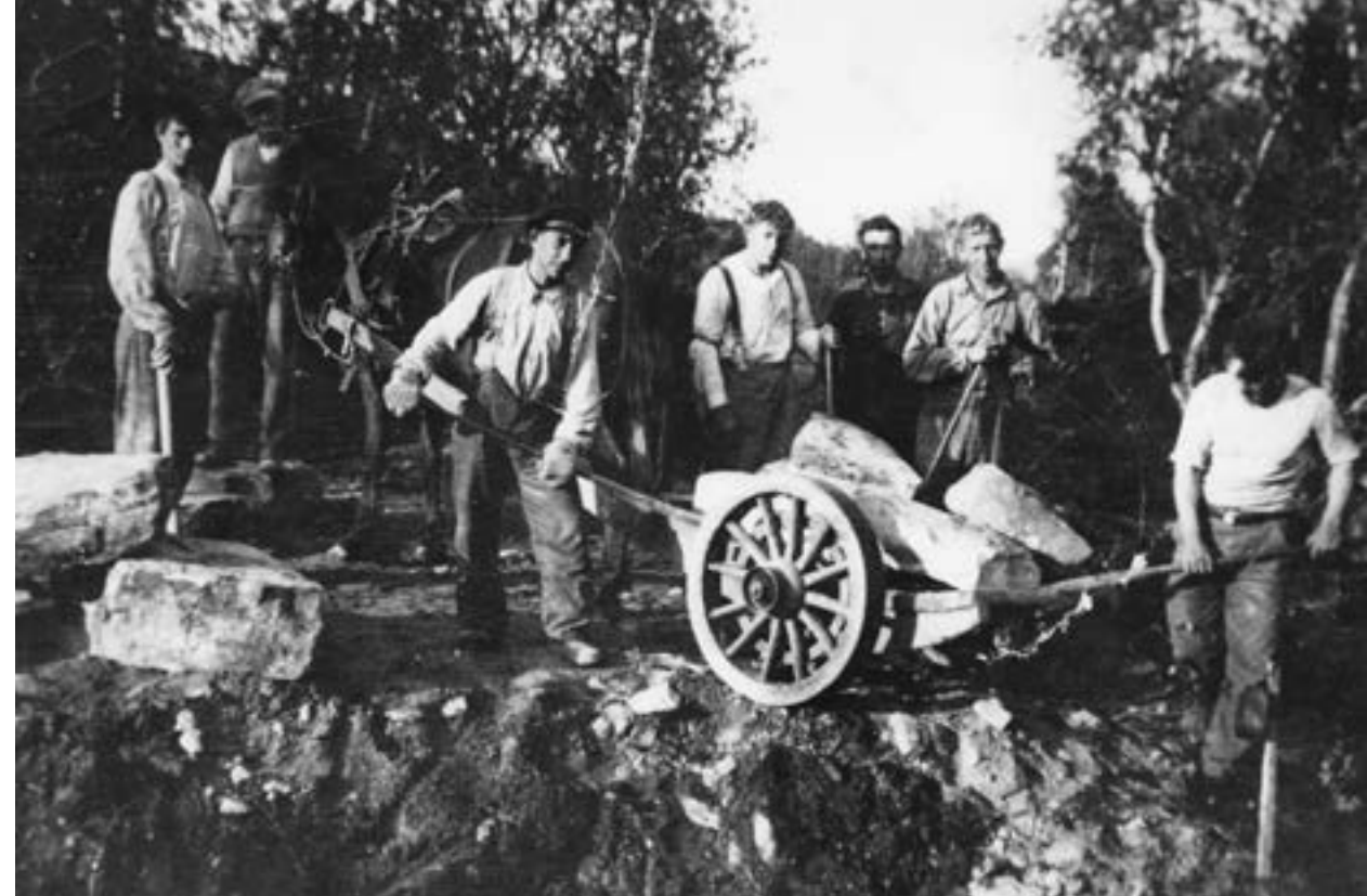
Vegarbeid kunne være svært tungt arbeid på denne tida og passet best for unge, sterke menn med erfaring. Her vises tungarbeid med transport av stikkrennestein fra veganlegget i Repparfjorddalen i 1937. (Foto fra Godtfred Karlsen sin fotosamling ved Norsk vegmuseum)
