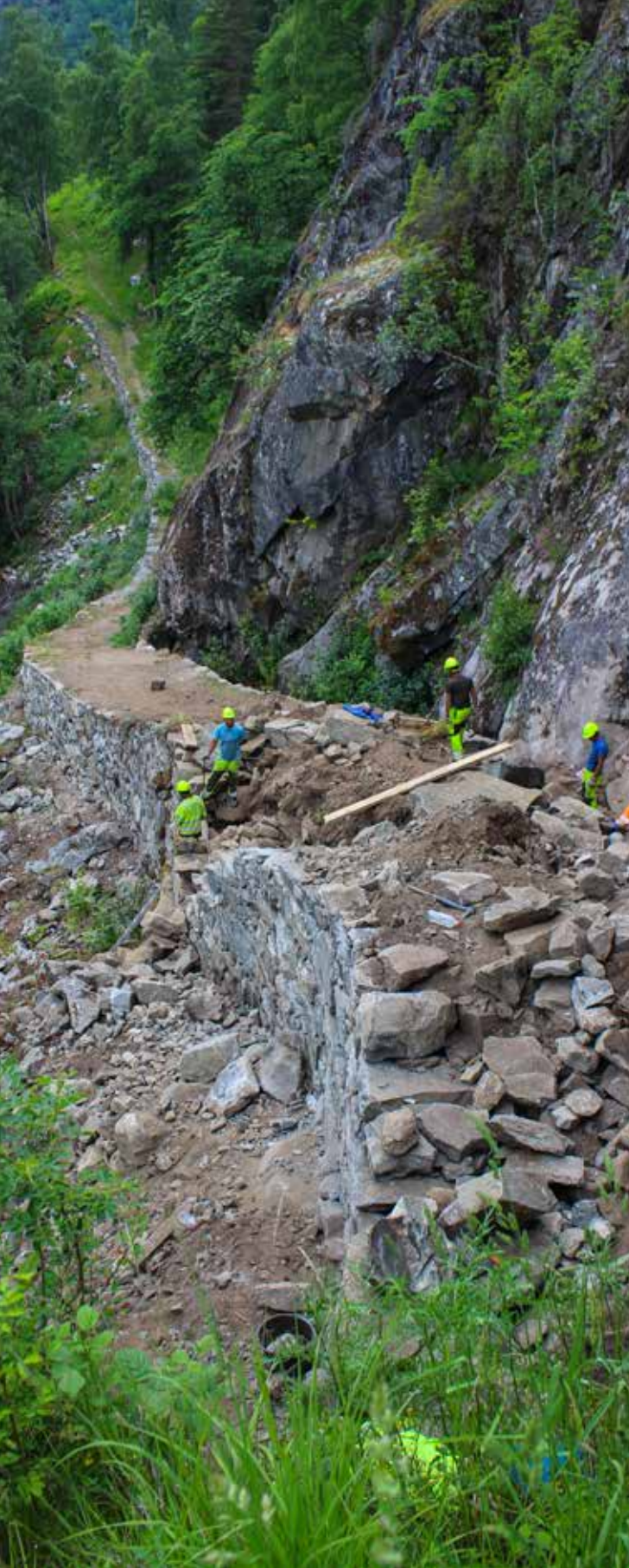
Sherpaene i full gang med å bygge opp igjen Laukebergbakken for hånd. (Foto: Jan Adriansen)
