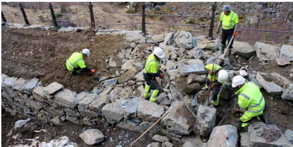
Løsmassen i vegkroppen erstattes med stein. Under topplaget binder store stein vegmuren innover. Dekket på toppen er jordblandet for at det skal binde seg. Fra Vindhella i Lærdal. (Foto: Jan Adriansen)
