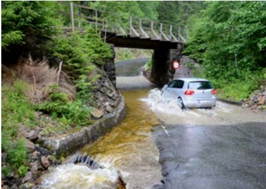
En side av beredskap er forebygging. Jernbanelundergangen for fv 44 ved Valebø mellom Skien og Notodden ble tidligere stengt ved kraftig regnvær. Et år etter at den ble utbedret sommeren 2016, var den kun blitt stengt en gang. (Foto: Torbjørn Tunesvik)
