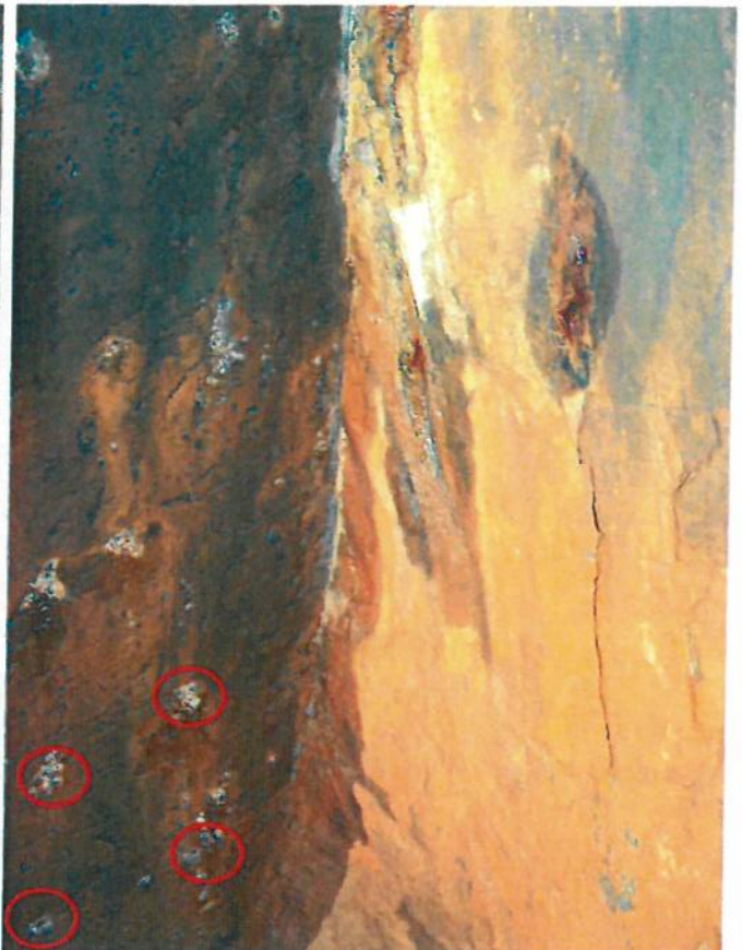
Bildene over viser hvor plan kilsumpens yttervegg er. I tillegg viser bildene den markante kanten (arbing) som er laget inn i stollveggen som et anhold for kilsumpen. En kan også se de typiske avleiringene fra hjømene på kubbene (røde sirkler).
