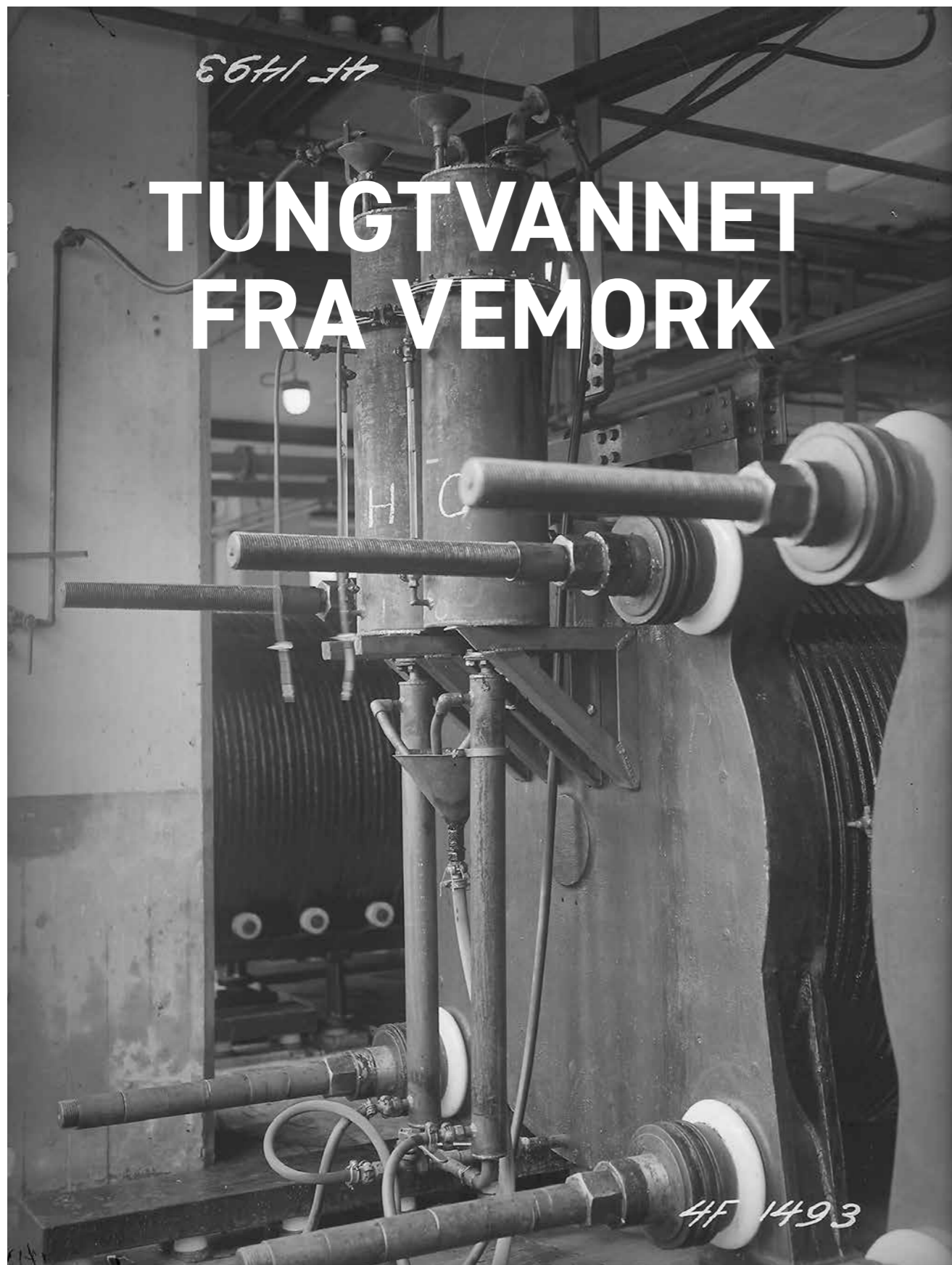
TUNGTVANNSAPPARATUR PÅ HYDROGENAPPARAT I 1934: Første fase av produksjonen av tungtvann foregikk trinnvis i apparatur som var montert på hydrogenapparatene. Foto: Norsk Hydros fotosamling/NIA
