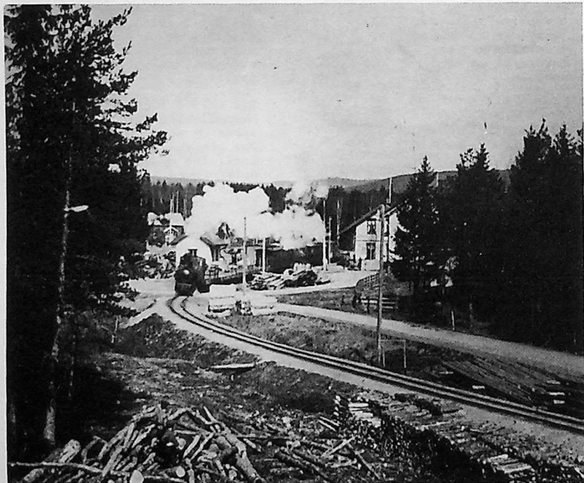
Urskog stasjon omkring første verdenskrig. Urskog fikk ny 2 etasjers stasjonsbygning i 1908. Den første bygningen (bak lokomotivet) står der uforandret, men ble senere forlenget og inngikk som en del av godshuset. Fotograf ukjent.
