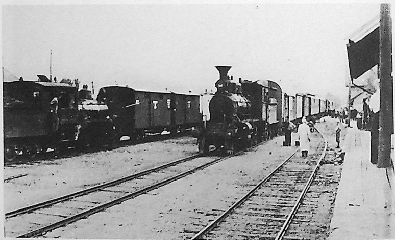
5/8 1941 var Rørosbanen ferdig ombygget til Normalspor. Bildet viser åpningstoget nordfra som har stanset på Tynset st. Bredspertoget har et lok av type 21, mens smalspertoget ved siden av har et lok av type XXIII d.
