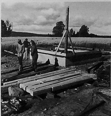
Øverst: Sporarbeider på Fossum. Nederst: Grunnmuren til Mork st.
