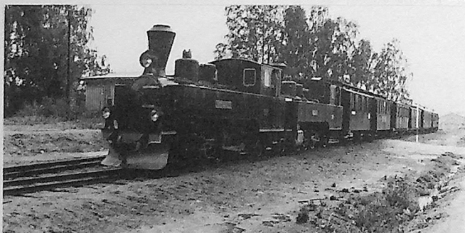
Etter at ytterligere 3 skinne- lengder ble lagt kunne togene frem- føres med alt perso- vognmateriel- let, og vel så det.
