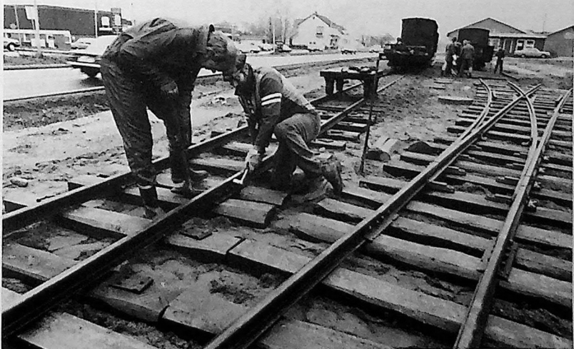
Sørumsand 24. oktober 1987: Øverst ser vi Roar Stenersen, Per Ivar Michalsen, Håvard Pedersen og Finn Halling legge ut en skinnestreng på uttrekksporet. Nedenfor er Ole Jonny Flateby og Vidar Skilnand i ferd med å skru sammen en lask. Lørdagen etter ble omkjøringssporet og uttrekksporet ferdigstilt. (E.B.)
