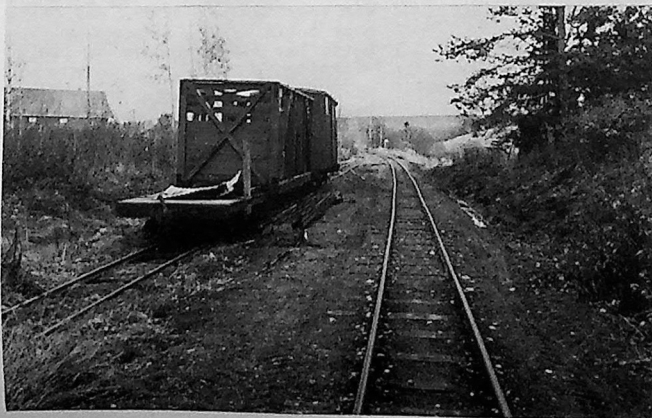
Sporveksel nr. 1 i Fyen er tatt opp. Fyen er nå degradert til lasteplass (Lp) Området er også grøftet. (E.Borgersen)
