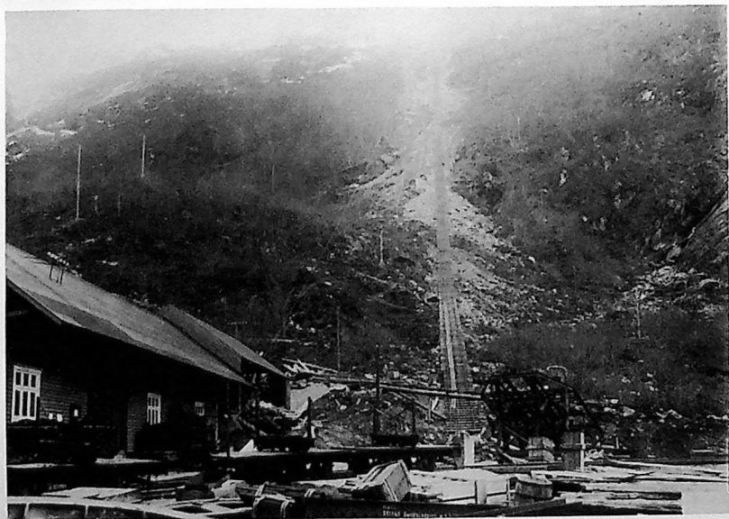
Øverst: Fra anlegget i Dalaråa, banen i forgrunnen. I bakgrunnen kraftverket Dalen 1 og utgangspunktet for heisen. Nederst: Fra anlegget av heisen, en av heisvognene sees på bildet.
