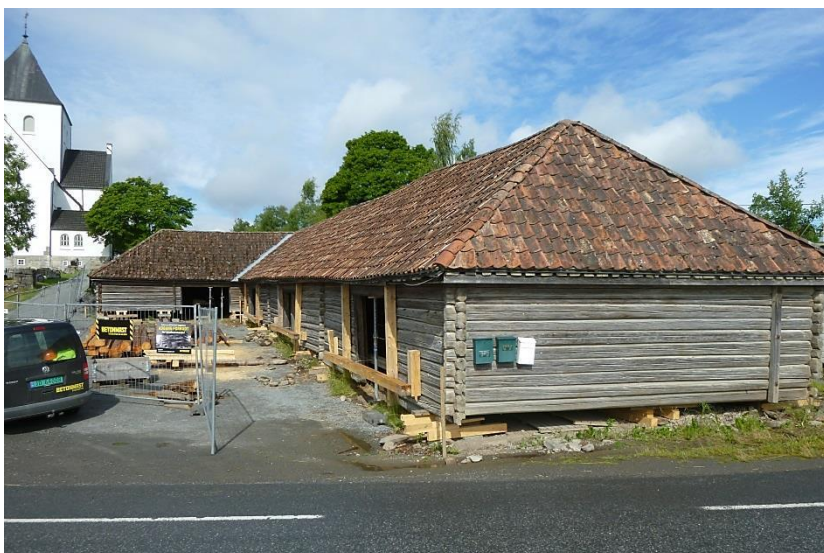
De fredete kirkestallene ved Ås kirke i Vestre Toten settes i stand med støtte fra Norsk Kulturminnefond, Stiftelsen UNI og Riksantikvaren. Foto: Betonmast Toten, avd. Bygningsvern.
