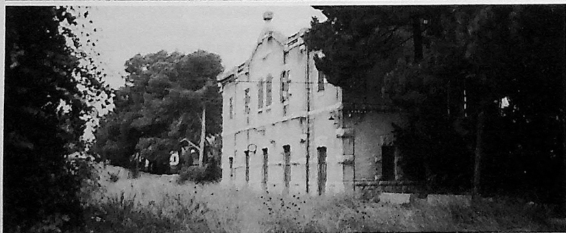
Øverst: Motorvogn nr. 2 klar med tog mot Palma under platantrærne på stasjonen i Soller 13.10.88. I midten ser vi sporgvogn nr. 3 med to sommervogner ved stasjonen i Soller, klar for avgang mot Puerto de Soller same dato. Nederst: Finnes det noe tristere enn en neilagt stasjon? Endestasjonen Arià 15.10.88
