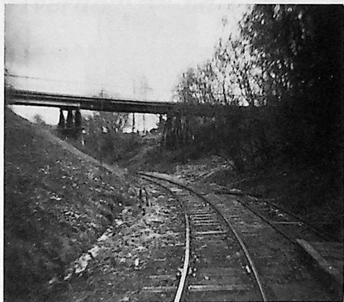
Tønsberg bro høsten 1967. Vi aner resten av svilleplattformen på Fyen st, som blir fjernet for å gi plass til Tønsberg tunnel. Tunnelen erstattet bro året etter. (Foto Håvard Pedersen)
