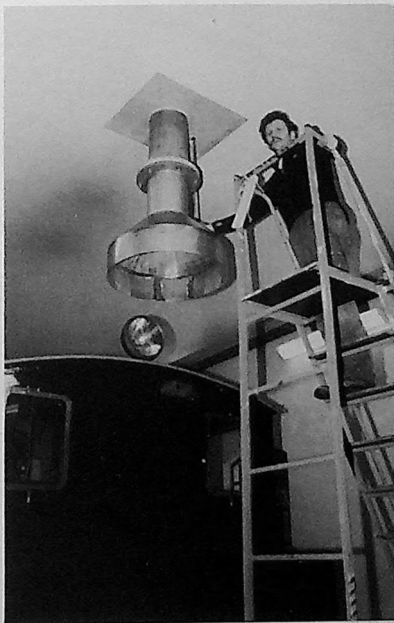
Montering av røykavtrekk vil muliggjøre oppfyring inne. Åge Malnes i sving med oppganven.
