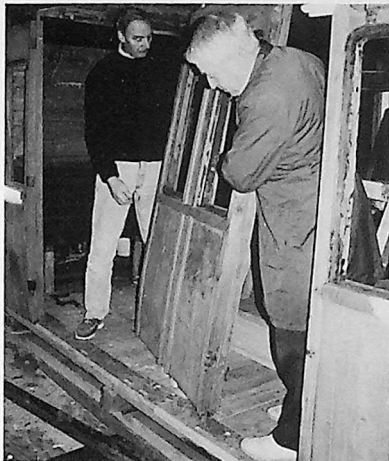
Borgarsyssel Museum nov. 1991. Bjørn Bjørnstad og Iver Østlie monterer veggseksjon til C 358. Foto: Roar Stenersen.
