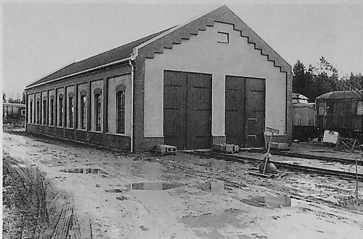
Ved årsskiftet var bygget lukket. Utvendig blir det en tilnærmet kopi av verkstedet på Bjørkelangen
