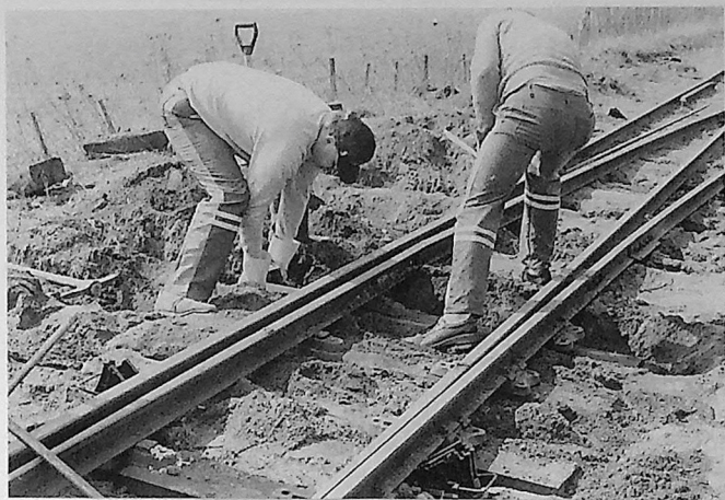
Svein Ove Johnsrud legger inn en ny kreosotimpregnert sville.
