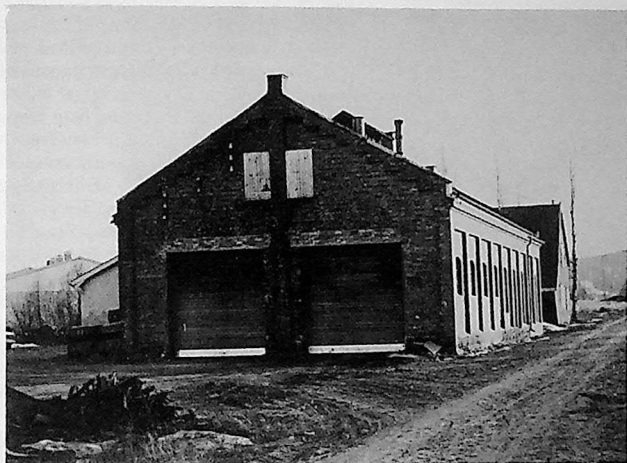
Lokomotivstallen på Bjørkelangen ble overtatt av Hølandsrutene etter UHB's nedleggelse. "Ombygging" som er foretatt i Hølandsrutenes regi vitner om total mangel på pietetsfølelse og forståelse for fin arkitektur
