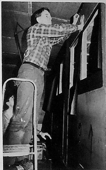
Prosjektleder Trond Dehli iferd med å sette plater på BCo2.
