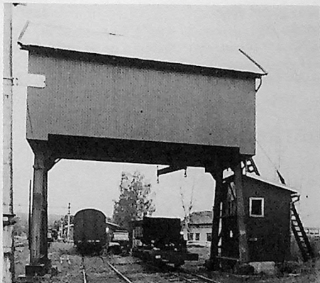
Portalkranen er pusset opp og overhalt.
