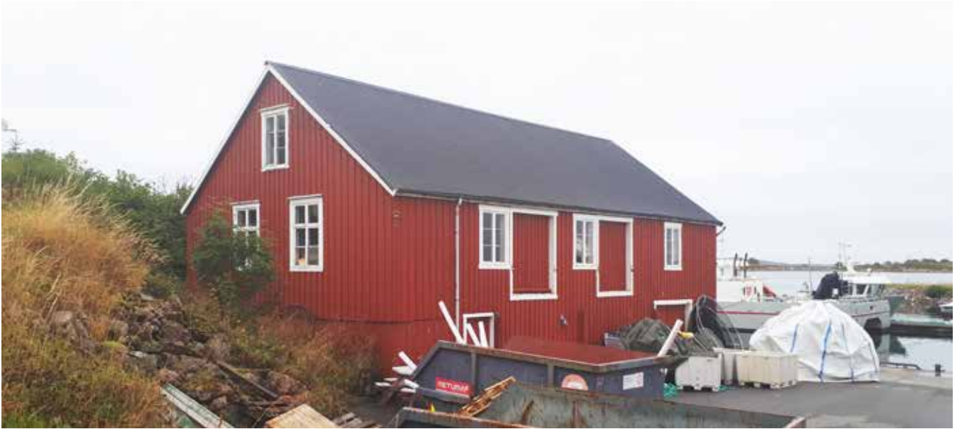
Bygningen slik den står i dag. Foto: Hans Jakob W. Farstad
