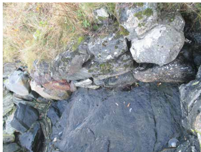
I Smifjærveiens veikant nede ved sjøen, på et flatt svaberg er rester av steinmuren som smia var bygd på opprinnelig. Det er en steinfylling oppå idag.
