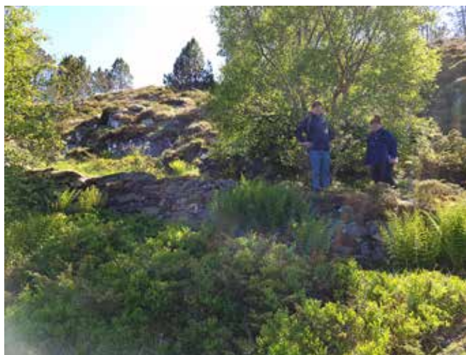
Det har vore lagt mykje arbeid i å bygge vegen utover Skreddarøya. I denne kleiva er han mura vakkert og solid opp.
