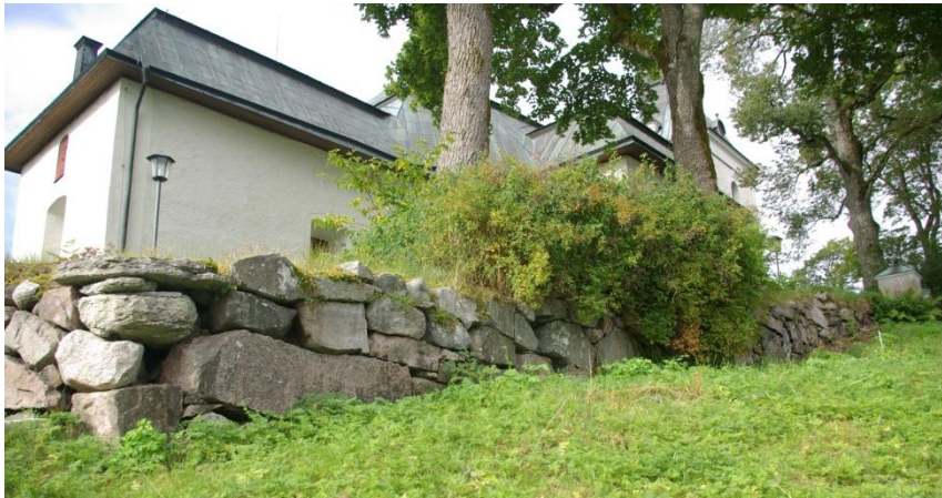
Nordöstra hörnet av stödmuren. Muren slutar vid norra samt bryts av vid östra ingången.
