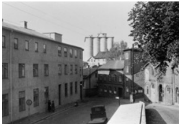
Vy österifrån på Viktor Samuelsons fabrik "Strumpan", omkring 1940. Till vänster om byggnaden rinner forsen och till höger Kvarnbygatan.
