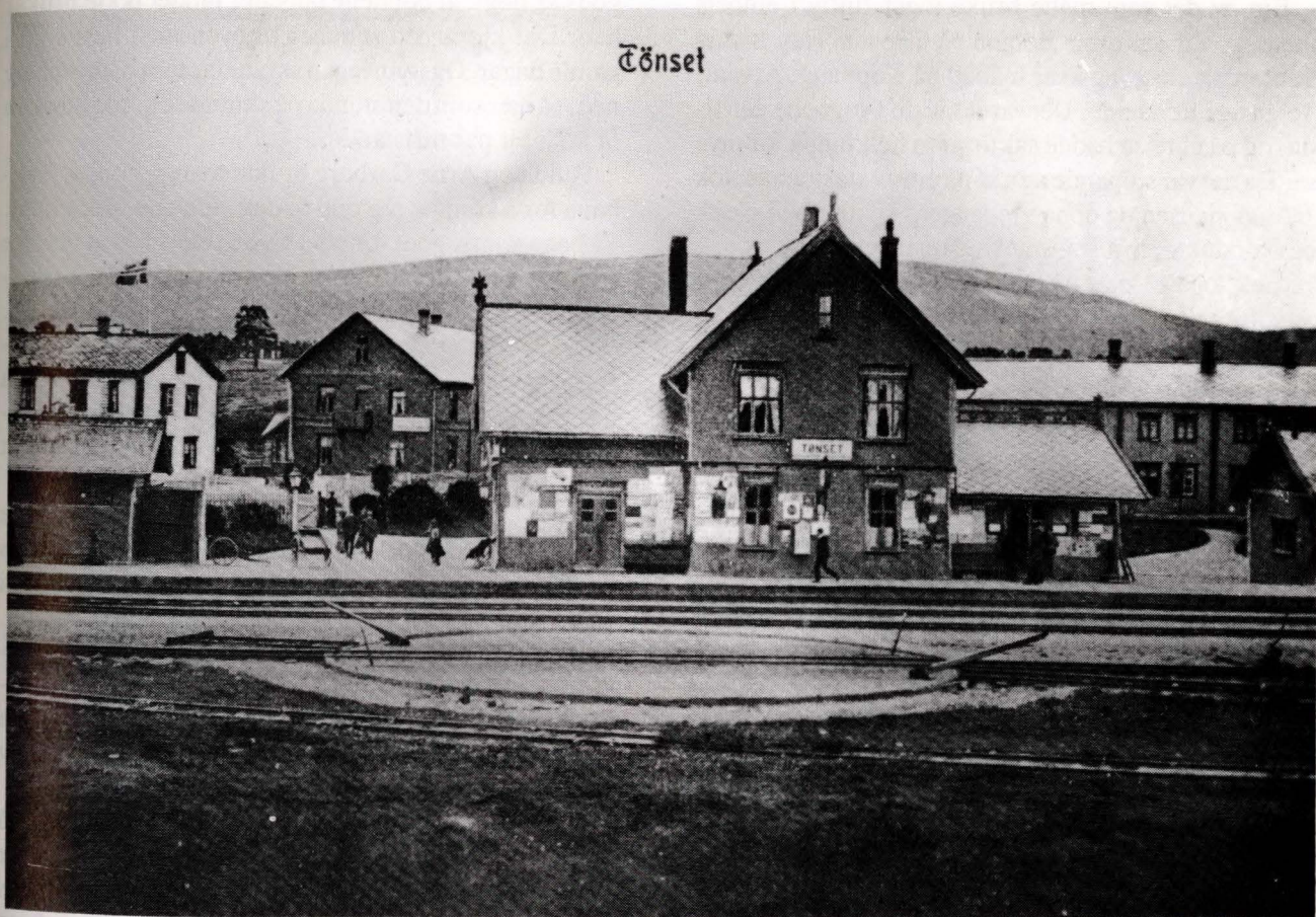
Tynset jernbanestasjon om lag 1900. Som vi ser har stasjonsbygninga halde seg stort sett uforandra, bare påbygd i ulike retningar. Derimot har omgivnadene forandra seg mye. Stasjonsbygninga er eit markert innslag i bymiljøet og er dessutan noe av det eldste som fortsatt fins, så den bør tas vare på, sjøl om NSB vil ha nye lokale.
