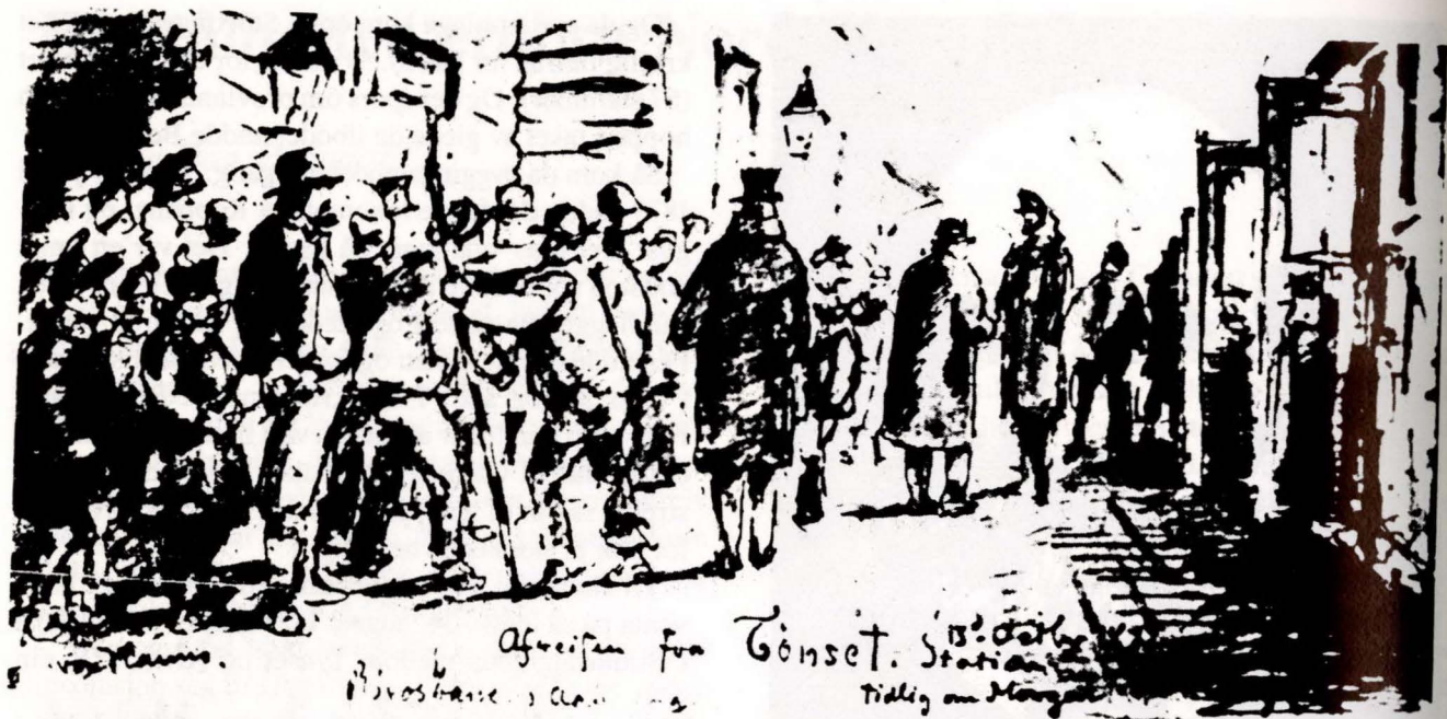
Opningstoget kom til Tynset fredag 12. oktober 1877, og reisefølgjet overnatta her. Teikning av V. Hanno utlånt av jernbanemuseet Hamar. Under står det skrive: «Afreisen fra Tønset Station 13. oktober 1877. Tidlig om Morgenen.»
