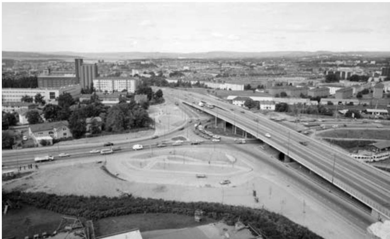
Sinsen-rundkjøringen fikk bedret kapasitet ved ombyggingen i 1970. Her er den fotografert i 1976. Men snart kom det behov for ny kapasitetsøkning. Det skjedde ved en ombygging der krysset ble lagt i tre plan. (Foto fra Arbeiderbevegelsens museum og arkiv)
