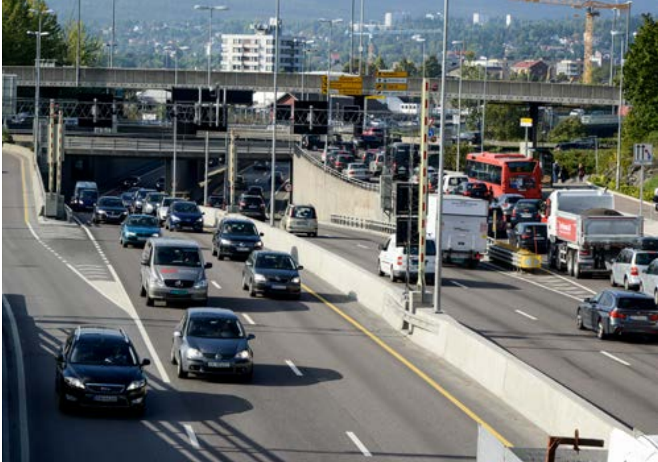
Sinsen-rundkjøringen er ikke landets første rundkjøring, men er regnet som den første moderne selv om den har hatt et konstant køproblem. Etter 13 år ble den bygd om til to-planskryss, og fra 1994 har den vært et avansert treplanskryss med bru over og tunnel under rundkjøringen. (Foto: Knut Opeide)
