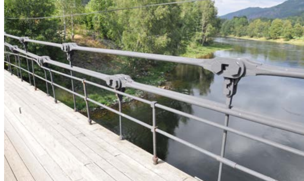
Beregning av styrken på hengestengene og utformingen av hengestengene på Bakke bru skape en bitter faglig konflikt ved byggingen av Bakke bru. (Foto: Håkon Aurlien)
