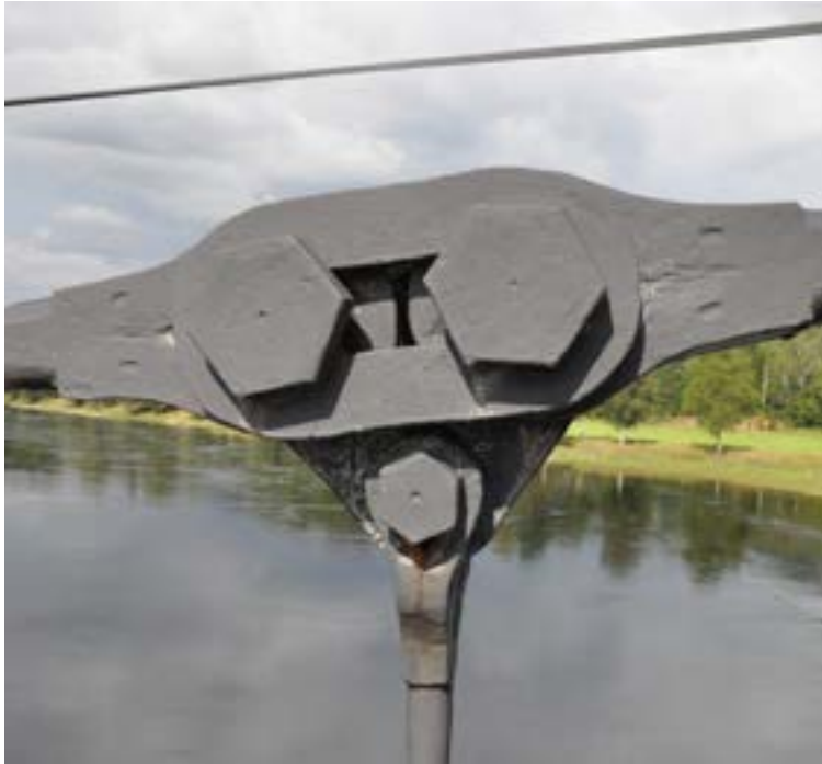
Til stor forskrekkelse for entreprenørene, ble kjedene demontert og delvis smidd om etter at Bergh overtok byggingen av Bakke bru i mai 1843. (Foto: Håkon Aurlien)
