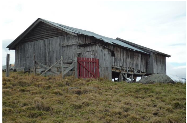
Reiestølen i Bjørndhøvd er ekstra lang, har utvendig panel og betongfundament:
