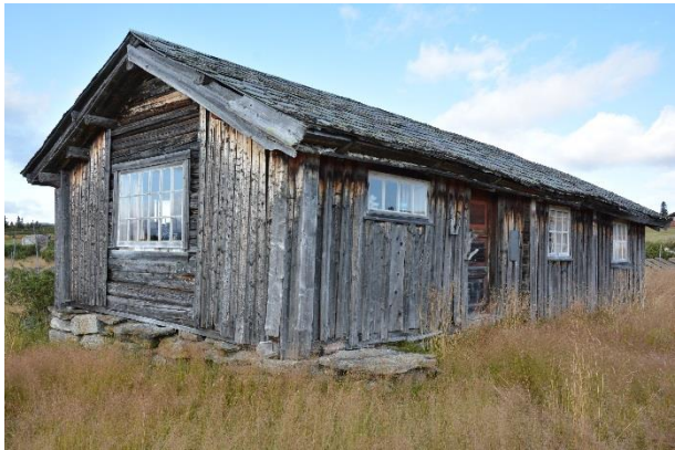
Bileta under, frå Tyrishøltx2 , Hermannstølen , Flyin , Nøsen og Gaukliex2 , viser andre døme på at det ligg tak av andre material oppå never og torv:
