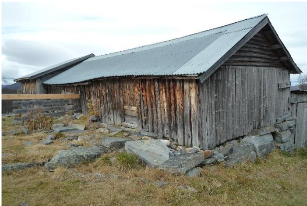
Reiestølen i Bjørndhøvd er ekstra lang, har utvendig panel og betongfundament:
