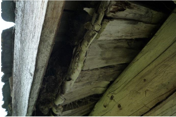
Bileta under, frå Tyrishøltx2 , Hermannstølen , Flyin , Nøsen og Gaukliex2 , viser andre døme på at det ligg tak av andre material oppå never og torv:
