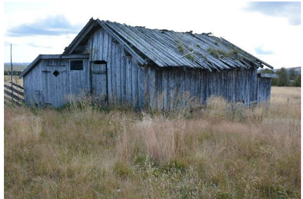
Bileta under, frå Tyrishøltx2 , Hermannstølen , Flyin , Nøsen og Gaukliex2 , viser andre døme på at det ligg tak av andre material oppå never og torv:
