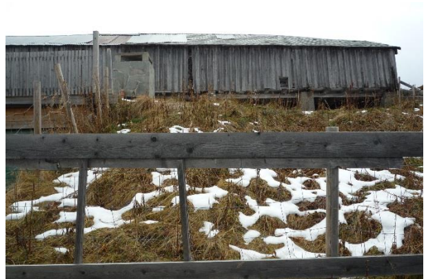
Reiestølen i Bjørndhøvd er ekstra lang, har utvendig panel og betongfundament:
