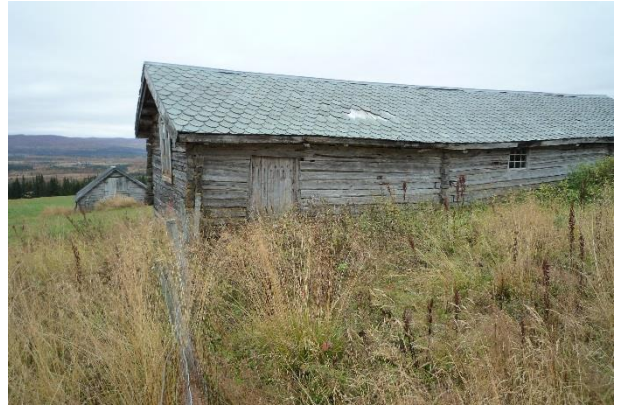
Bileta under, frå Tyrishøltx2 , Hermannstølen , Flyin , Nøsen og Gaukliex2 , viser andre døme på at det ligg tak av andre material oppå never og torv:
