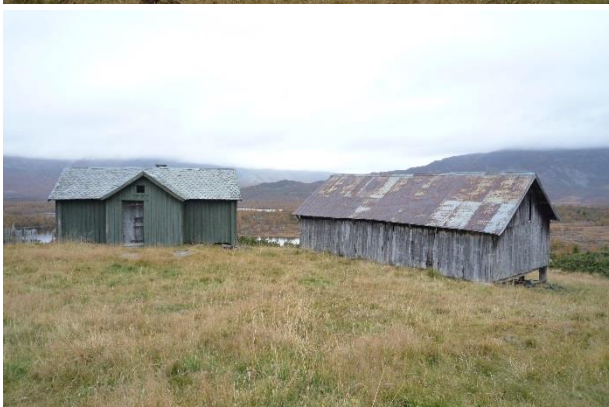
Sela under står på Gjølmyr og i Strø . Dette er eldre sel som liknar dei på bileta over. Begge har på eit seinare tidspunkt òg fått tilbygg i lengderetninga. På selet i Strø (til høgre) er mjølkebua intakt, med ei open sjåglugge i kvar ende.
