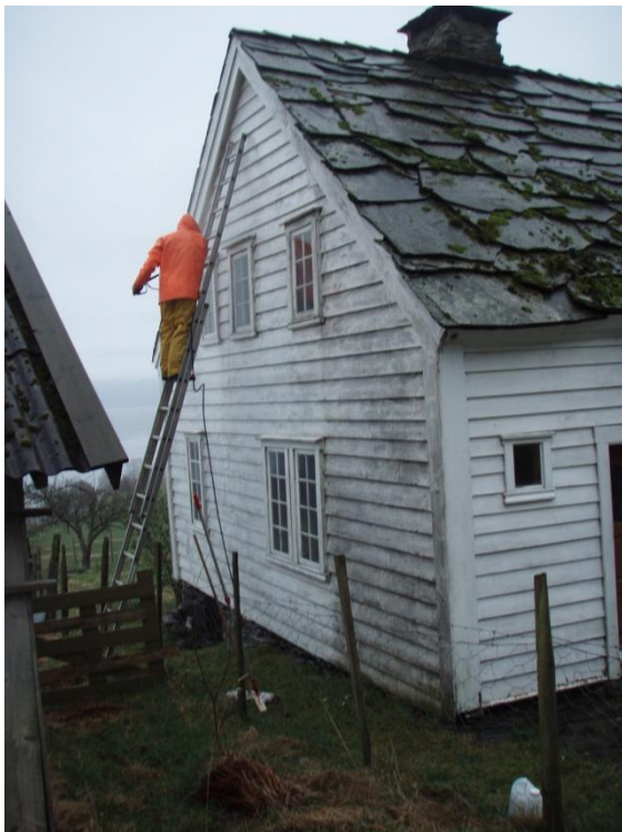
Det fuktige klimaet og aukande angrep av svertesopp gjer at vask og maling krev store ressursar. Foto frå Veien. Haugalandmuseene 2008.
