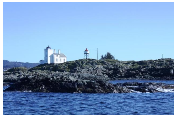
Tonjer fyr, ved innseglinga til Smedasundet i Hauge-sund, har vore brukt som klubbhus for ein sportsdykkarklubb i 30 år. Det har eit stort potensiale for formidling av kunnskapar og opplevingar, men her er behov for både planar for ny bruk og pengar til å realisere planane.
