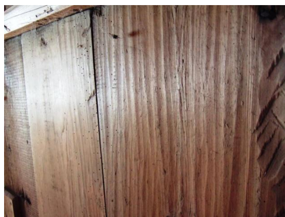
Bygningskompetanse omfattar også kompetanse til å sjå og forstå spora etter det som har vore gjort tidlegare. Dette er ein del av grunnlaget for å gjera riktige val i arbeidet med vedlikehald av bygningane.
