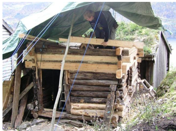
Dei delane som må skiftast ut må erstattast av tilsvarende materialar, med tilsvarende teknikk og i tråd med faglege tradisjonar på staden der bygningen hører heime. Sauhuset på husmannsplassen Røynevarden, Suldal, 2009.
