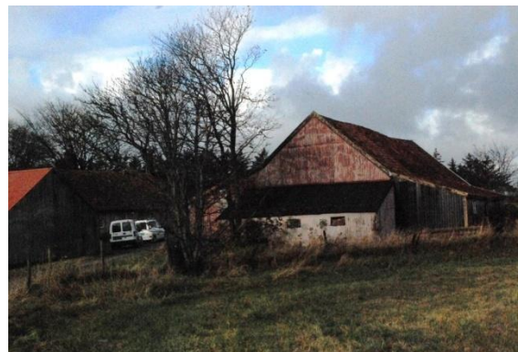
Løa på Audamotland i Hå har grunnmur i kilt stein og fjøs med mura vegger og støypt golv.
