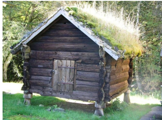
Bleskestad-stabburet frå 1667 er ført opp med raulandslaft.
