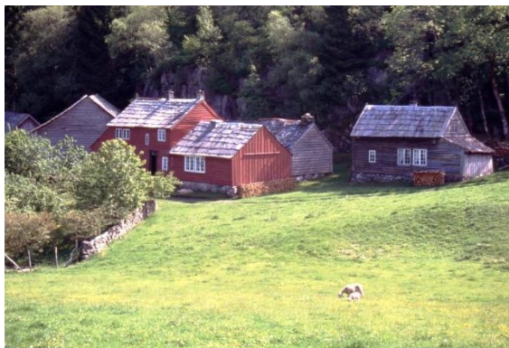
Ryfylkemuseet har starta eit omfattande restaureringsarbeid i Viga-tunet.
