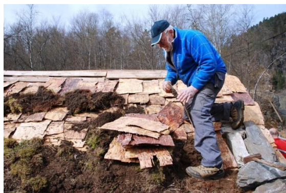
I grenseland mellom vedlikehold og reparasjon: Omlegging av taket på mellomalderloftet frå Guggedal sommaren 2010. Ei ordinær oppgåve som hadde måtta vente litt for lenge.
