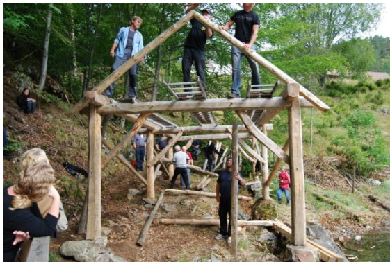
Naustet på Kolbeinstveit blei rekonstruert med grunnlag i tomte det opphavlege naustet hadde stått på, gammalt foto og kunnskap om tradisjonshandverk, stavkonstruksjonar og naustbygging kring Suldalsvatnet.
