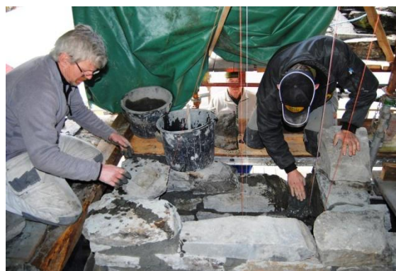
Grua på Viga under gjenoppbygging. Muring med leire var ein kunnskap som var mest forsvunne frå Ryfylke. Museet henta han inn att gjennom eit samarbeid mellom ein tradisjonsberar frå Setesdal (Eystein Greibrokk til venstre) og lokale tradisjonsberarar. Museumshandverkar Sven Hoftun til høgre.
