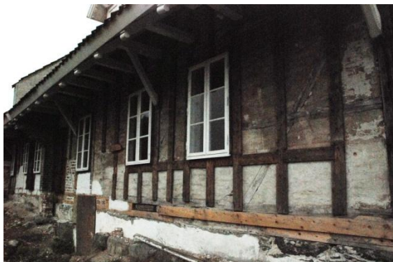
Under arbeid med restaurering av Holm-Egenes i Stavanger er det avdekkja eit godt døme på bindingsverk. Bygningen er i eiga til Stavanger kommune, men det ligg føre planar om overføring til Stavanger Museum.
