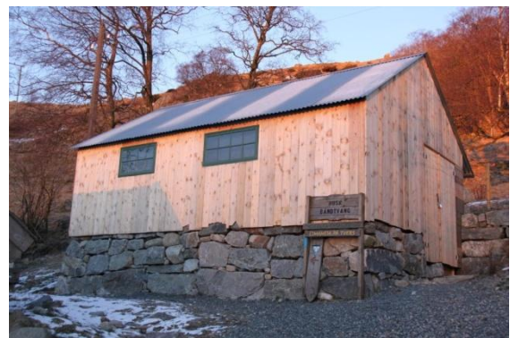
Blekkhuset etter riving og gjenoppføring som utstillingshus.
