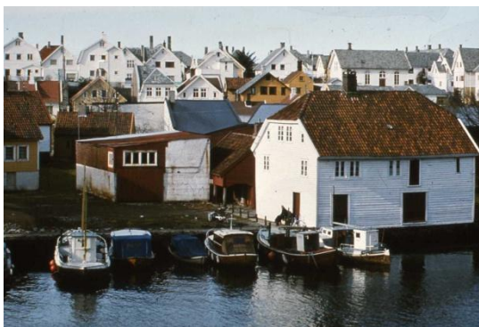
Dokken i 1987, Ferkingstadhuset, før museet bygde båthall ved sida av.
