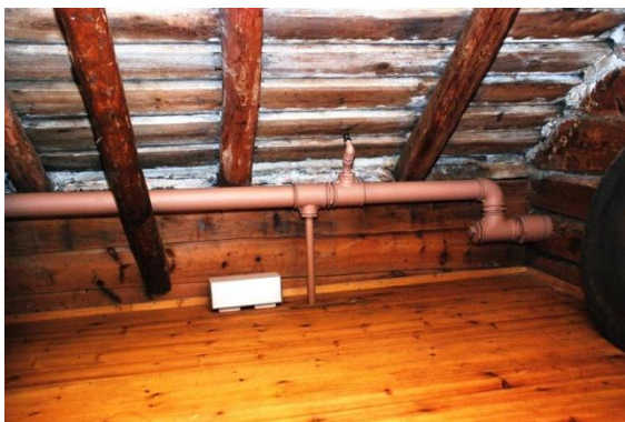
Det er ikkje sikkert det er nødvendig å montere sprinklaranlegg i ein bygning utan innlagt straum.
