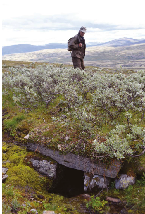
Stikkrenne i vei oppe i gruveområdet. Foto: Arild Alander / Musea i Nord-Østerdalen, 2017 (126184).
