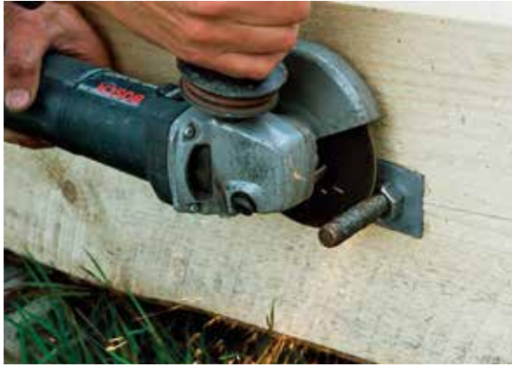
Stagende kuttet med vinkelsliper.
