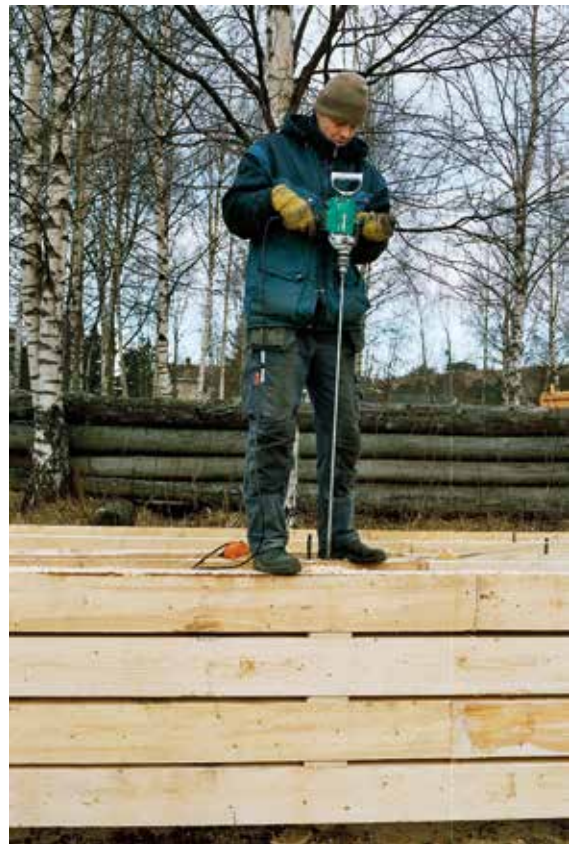
Boring gjennom flåstokkene.
