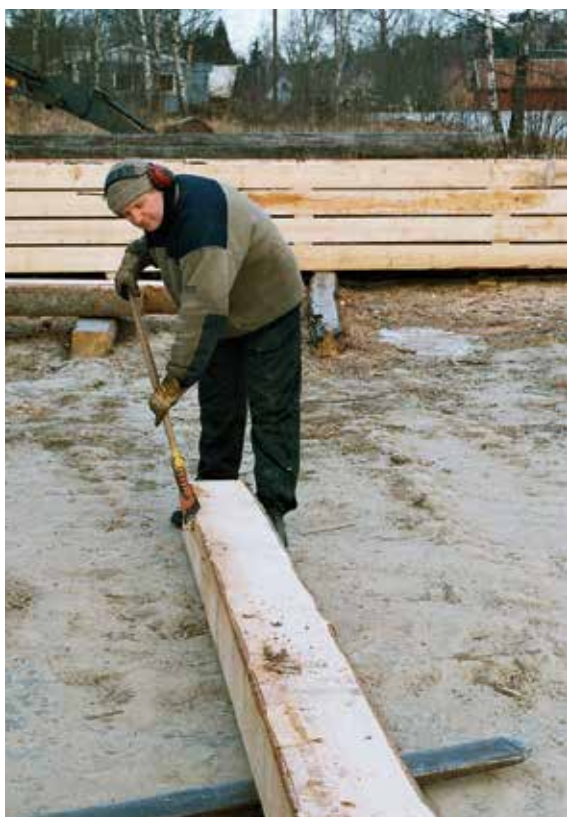
Bark på kantene fjernes for å hindre forråtnelse.
