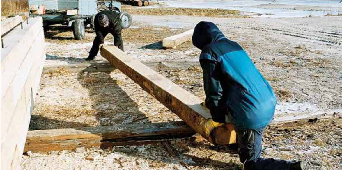
Første stokk til en flåte legges ut.
