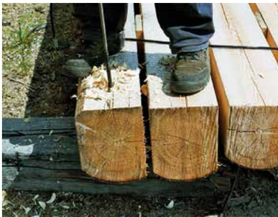
Boring av kjettinghull.
