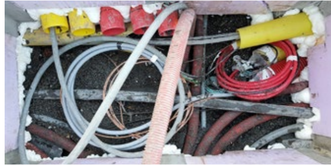
Det er mye som skal på plass av sterkstrøm, svakstrøm og diverse signalkabler. Foto: Espen Revold, Norsk Folkemuseum.
