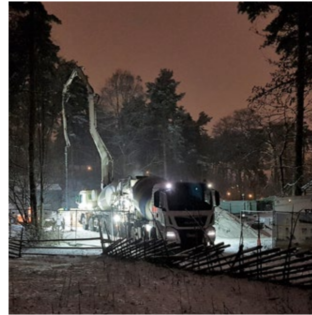
Ole Andreas Persen har nok blandet sement, sand og vann med spade. Han har lett etter egnet sparestein til grunnmuren og fraktet alt på plass med trillebår. I vår tid kan vi støpe grunnmur uten å slite ut ryggen. Foto: Espen Revold, Norsk Folkemuseum.
