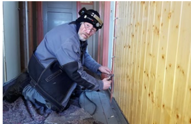
Arnfinn Kaaby fra Børselv i Porsanger har fulgt prosjektet fra det startet, og han har vært til stor hjelp. Før bolighuset i Olderfjord ble tatt ned demonterte Arnfinn de gamle kulokablene, og på bildet er han i gang med å sette det historiske anlegget opp igjen på museet. Foto: Espen Revold, Norsk Folkemuseum.
