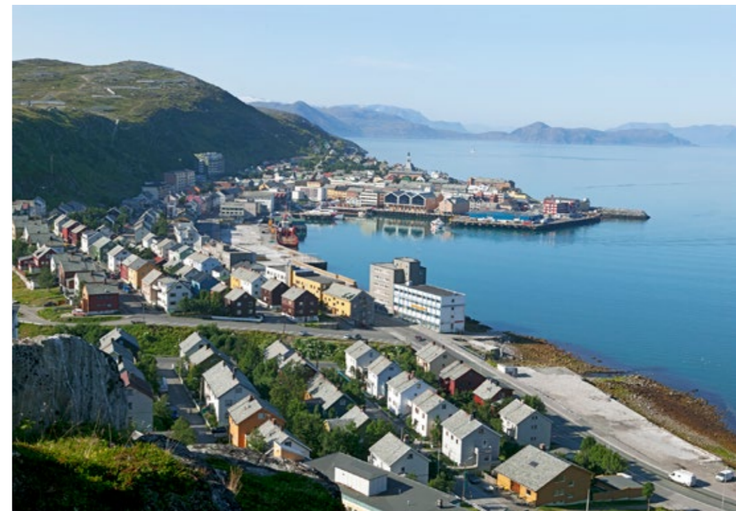
Hammerfest 2004. Gjenreisningshusene, som i byer og tettsteder ble lagt på rekke og rad med samme avstand til gaten og i samme mønere, preger fortsatt bybildet. Foto: Oskar Puschmann, NIBIO.
