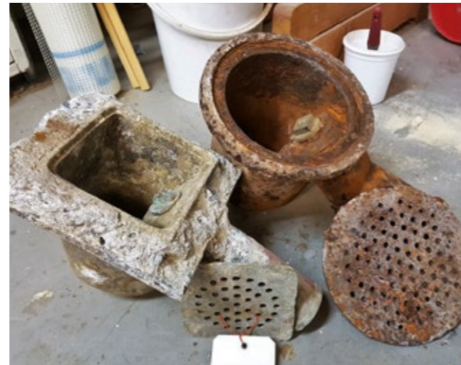
De opprinnelige slukene fra bryggerkjelleren og saunaen er på plass igjen, men det har ikke vært mulig å legge vann inn i huset.
