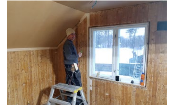
«Geyfuspanelet», som de frivillige fra venneforeninga renset for maling, blir satt på veggen av tømrer Magnus Nordli.
