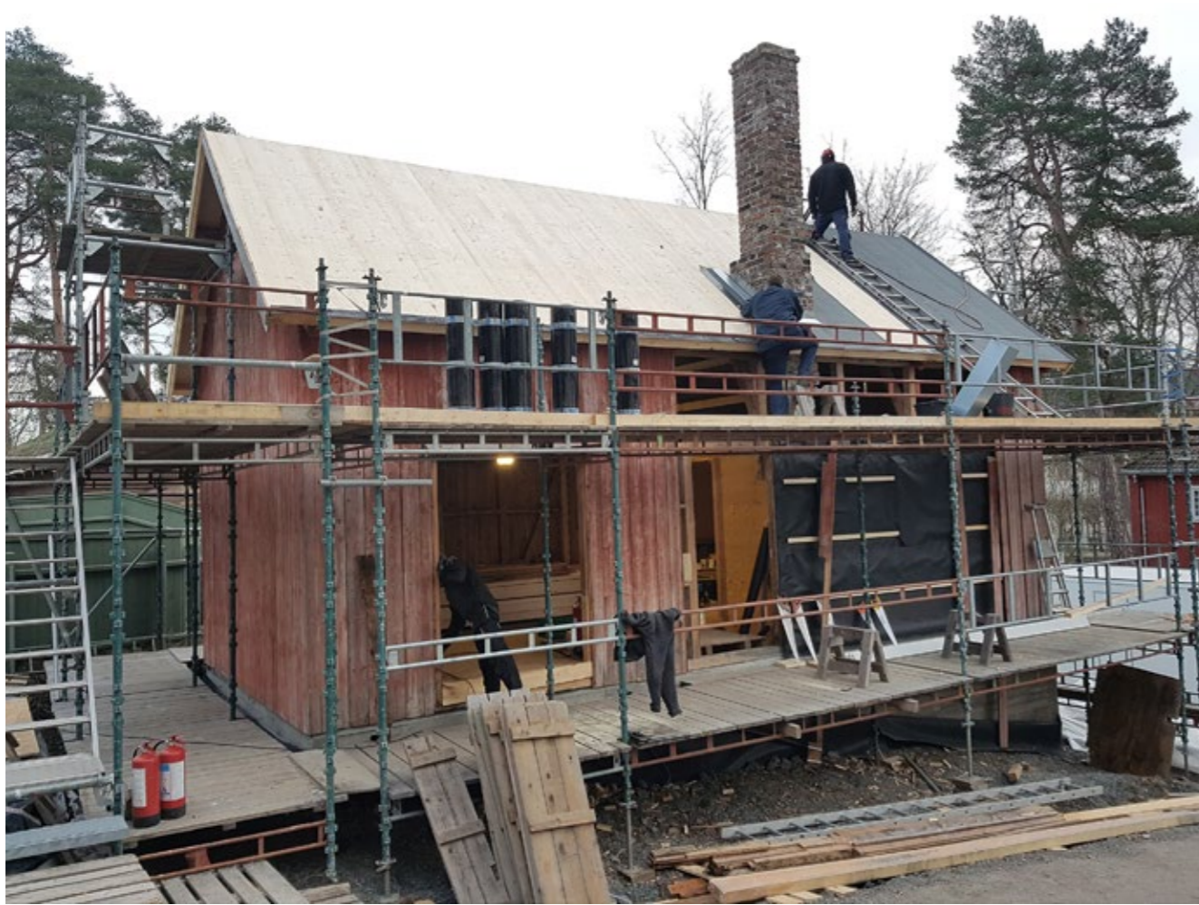
Pipa er ferdig, blikkenslageren beslår pipa og taktekerne er i gang med papptekkingen. Foto: Espen Revold, Norsk Folkemuseum.
