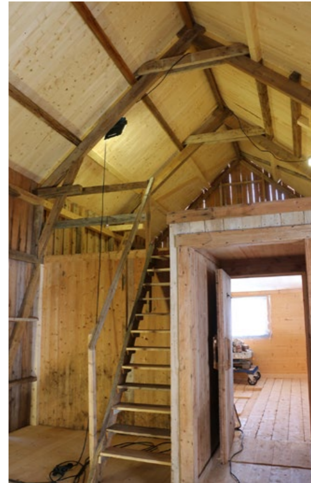
Låven er ferdig innvendig. Legg merke til takkonstruksjonen som består av sperrebind med knebukker. Foto: John Wennberg, Norsk Folkemuseum.
