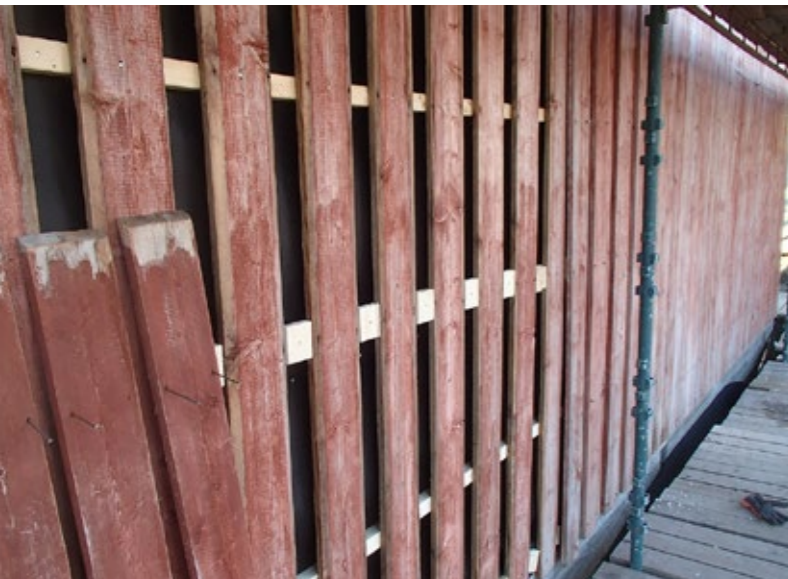
All utvendig kledning ble satt opp igjen på sin opprinnelige plassering.
