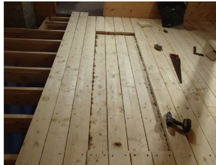
Gulvet i fjøsdelen ble telgjet på kantene slik at det dannes et v-spor når de legges inntil hverandre. I sporet ble det drevet inn dyttestrie. I den nedsenkede delen av gulvet blir det to møkkluker, som det var opprinnelig.
