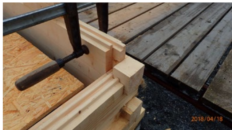
Den samme lafteteknikken var brukt i fjøset fra Indre Billefjord. Det sies at dette laftet er en kvensk tradisjon. Foto: John Wennberg, Norsk Folkemuseum.
