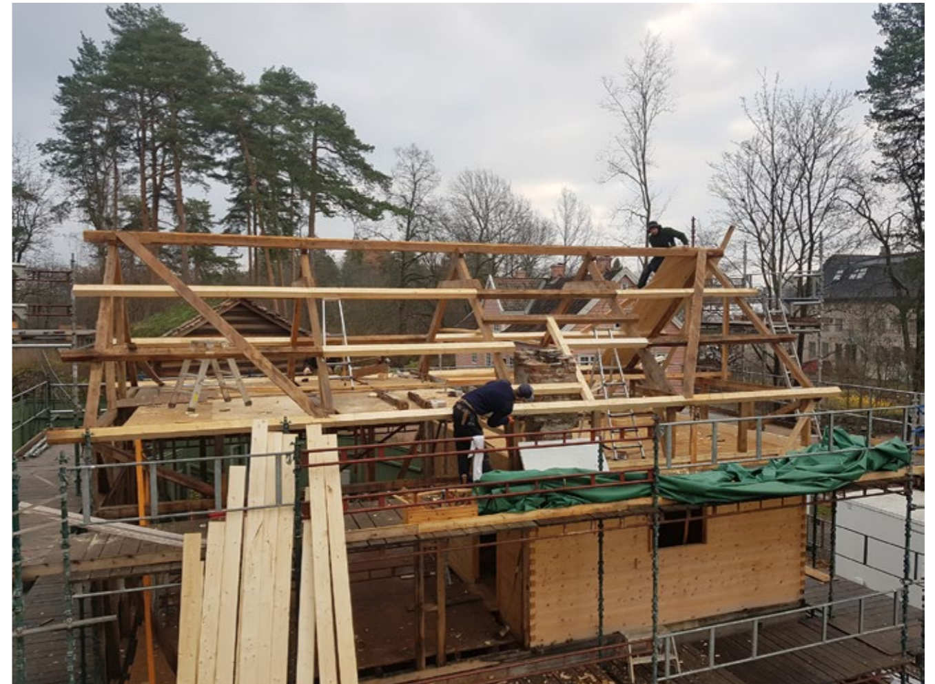
Bindingsverk og takverk er komplett og legging av stående taktro er i gang. Ved nedtaking i Finnmark ble pipa ble demontert i flere større deler og heist opp igjen med kran på museet. Foto: Espen Revold, Norsk Folkemuseum.
