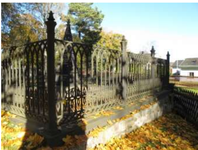
Stor gravvård med påkostat staket där även sockeln är av gjutjärn. Staketet har ett märksystem för montering. Gravvården är rest år 1850.
