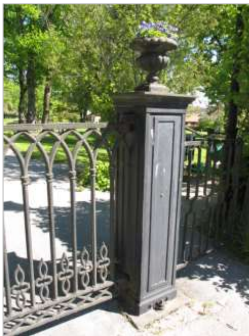
Gjutet staket, gjutna grindstolpar samt gjutna blomsterurnor som kröner grindstolparna. Norra kyrkogården i Nora.
