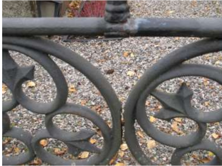
Staket, troligtvis från början av 1900-talet. På bilden till höger kan man se en lödning i överliggaren och att sektionen glidit isär.
