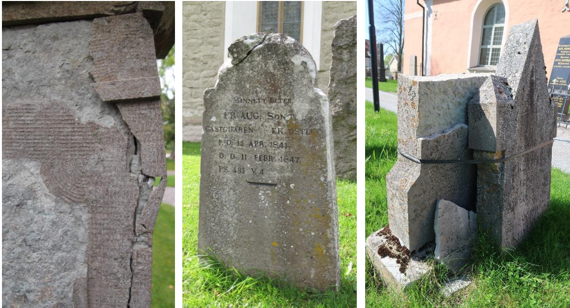
Bilderna ovan visar på olika skador som flera av gravvårdar av kalksten kan ha. Vittring, skador efter frostsprängning, sprickor, gått av vid provdragning för gravstenssäkerhet m.m.
