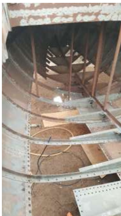
Kjøplater BB og SB ferdigstilt og lekkasjetestet OK
