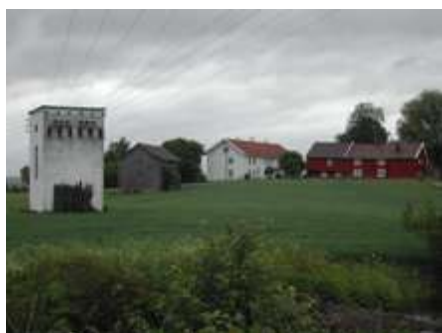
Foto 31: Trafostasjon ved Jevnaker prestegård.
