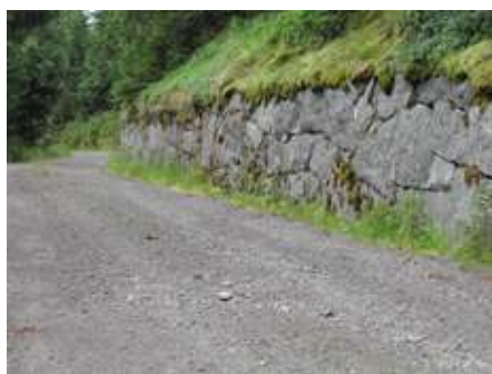
Foto 30: Forstøtningsmur ved Gjerdingvegen i Nordmarka
