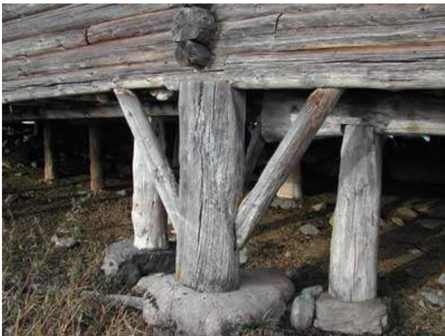
Foto 187: Estetisk utforming av fundament og laft på Åmbuset Seter i Nordsinni
