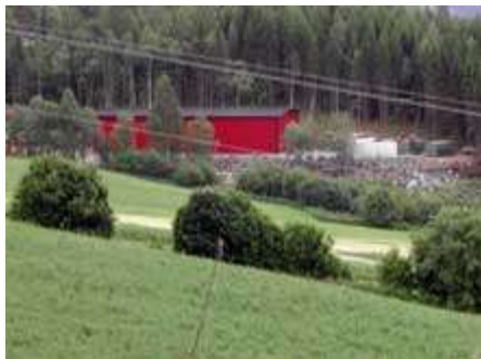
Foto 127: Nybygd lagerhall i kulturlandskap, Østsinni Nordre Land
