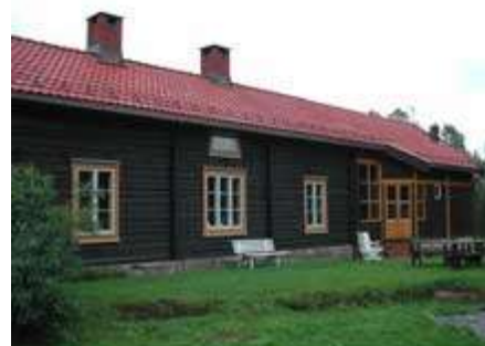
Foto 140: Laftet bygning med tilbygg i stavkonstruksjon, Vestbygda i Lunner.
