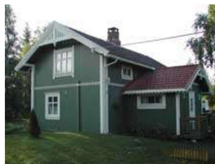
Foto 138: Nytt vindfang i samme stil har gitt plass til våtrom, Jaren i Gran.
