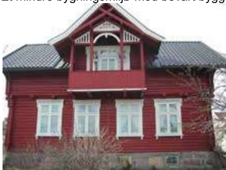
Foto 154: Bolig ved Lunner stasjon
