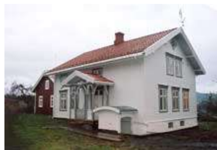
Foto 131: Rehabilitering og tilrettelegging for kårbolig på Jorstad, Tingelstad i Gran
