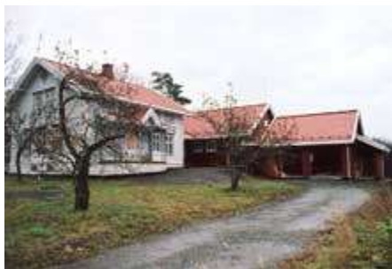
Foto 130: Rehabilitering og tilrettelegging for kårbolig på Jorstad, Tingelstad i Gran
