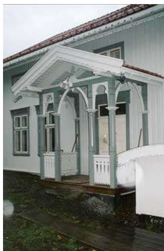
Foto 132: Rehabilitering og tilrettelegging for kårbolig på Jorstad, Tingelstad i Gran
