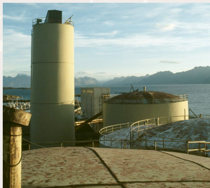
Oversiden av tankene på Neptun sildoljefabrikk. Foto: Ola Hektoen Øverås, Riksantikvaren
