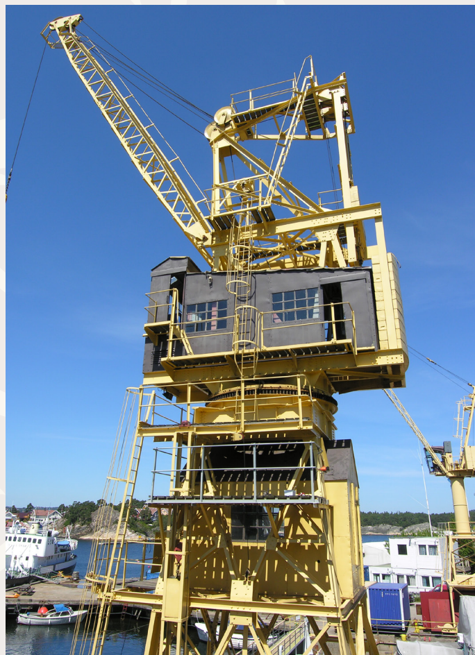
Kran 24. Foto: Endre Wrånes
