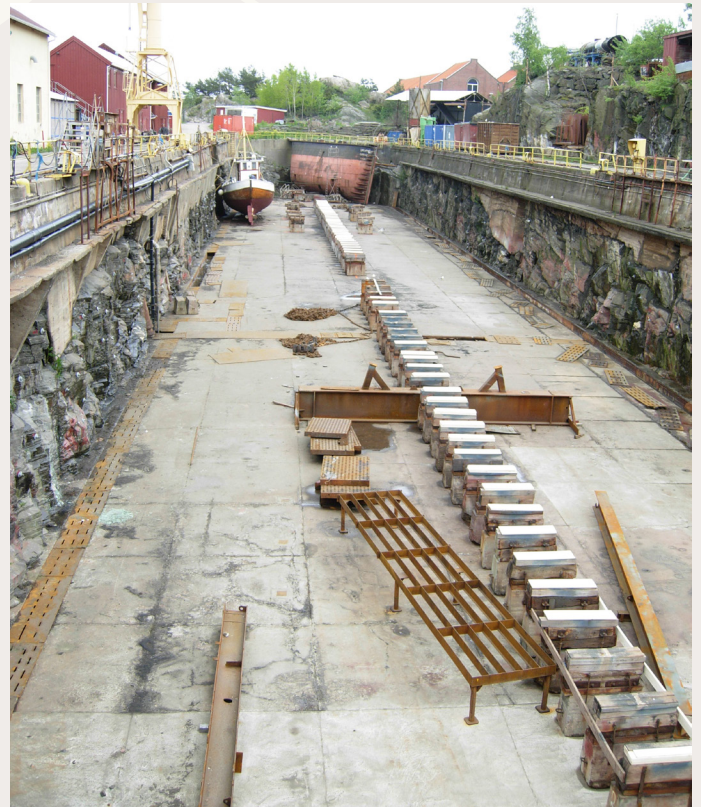
Tørrdokka med det gamle dokkskipet innerst i dokka. Foto: Svein Jakob Vik Sâghus
