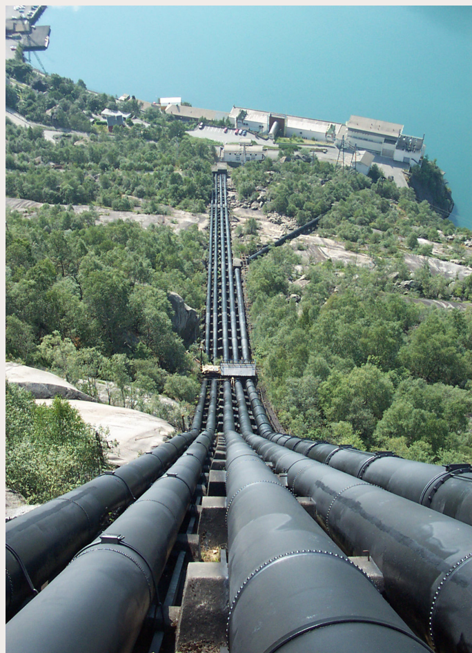
Den 730 meter lange rørgata går bratt opp kraftstasjonen til fordelingsbassenget på Lilletopp, som ligg 400 moh. Foto: Harald Hognerud, NVIM
