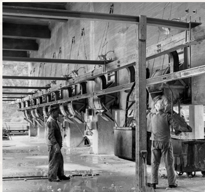
Produksjonen starta med at vaggene på taubanen vart lasta med kol og kalkstein ved importanlegget. Fotograf ukjent
