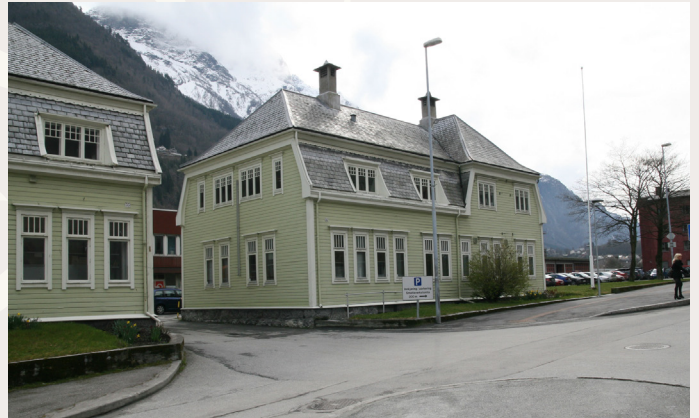
Inngangspartiet til Odda smelteverk. Foto: Ulf I. Gustafsson, Riksantikvaren
