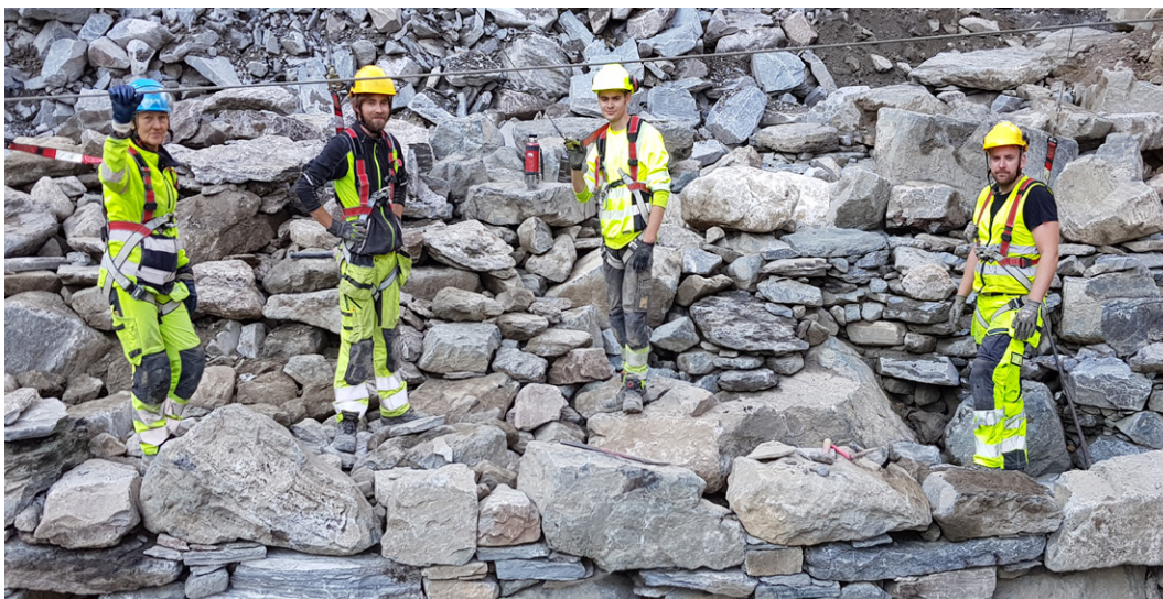
Tørrmurane i aksjon. Frå venstre Berit Bruvik som leia arbeidet, Sivert Vik Skjerdal, Endre Kolve Nilsen og Robin Andre Toftum Mikkelsen. Murarane nytta fall-sikringssele då muren vart høgare enn to meter (Foto: Ann Kristin Engh)
