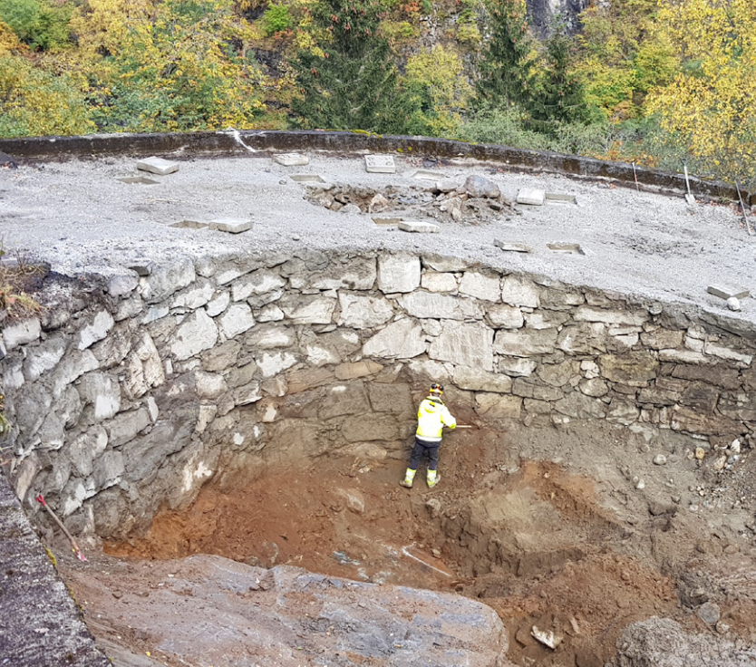
Då arbeidet starta, var innersvingen fylt igjen med massar. Overraskinga var stor då det viste seg at innermuren var nesten like høg som yttermuren. Til høgre: Etter at vegen var rasa ut. (Begge foto: Ann Kristin Engh)
