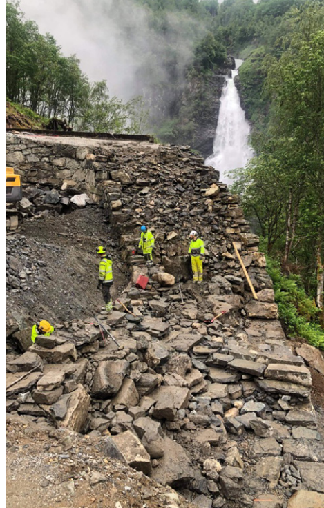
Då arbeidet starta, var innersvingen fylt igjen med massar. Overraskinga var stor då det viste seg at innermuren var nesten like høg som yttermuren. Til høgre: Etter at vegen var rasa ut. (Begge foto: Ann Kristin Engh)
