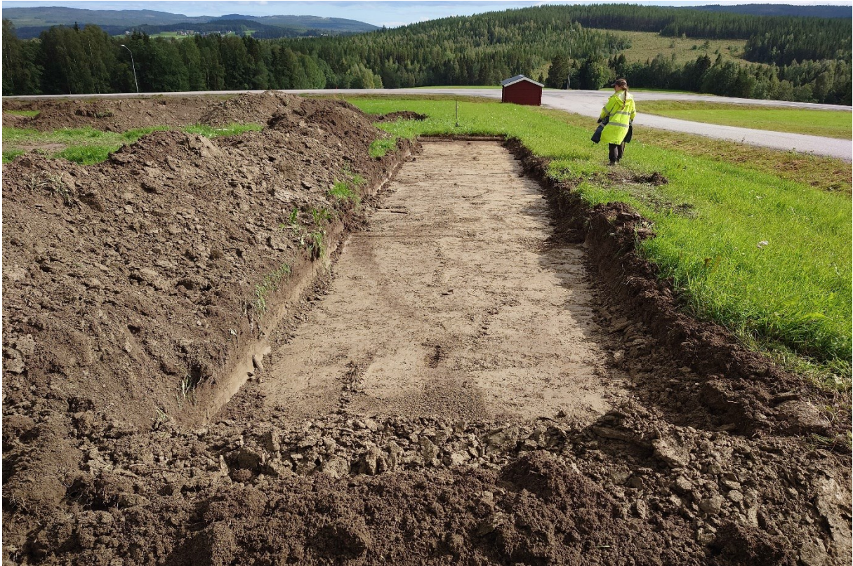
Figur 5. Schakt 15 från nordväster.
