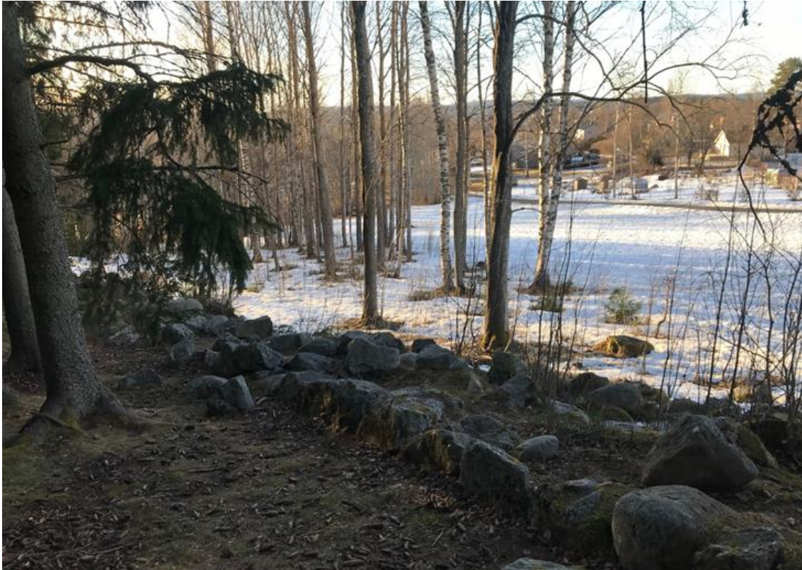
Figur 11. Muren i förgrunden och ytan där kapellet kan ha legat i bakgrunden. Foto från öster.
