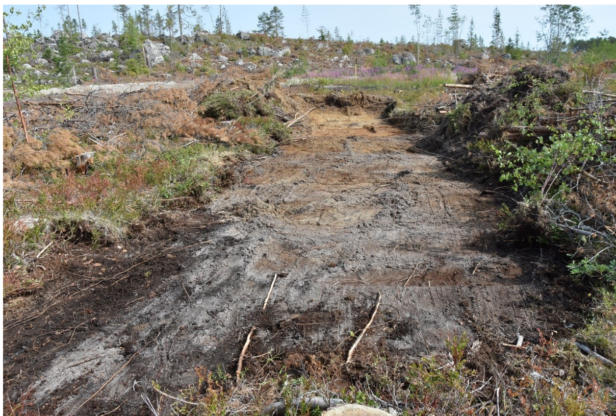
Figur 13. Schakt 33 sett från S.
