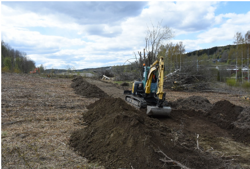
Figur 31. Schakt 9, foto från Ö. I väster verkar det vara matjordsavbanat. Tunn matjord. Grusigt och småsten, i mitten/östra halvan något lerigt och blött. Några bitar obearbetad flinta hittades i östra delen av schaktet. Myntfynd och knappar m.m. i och runt schakt 9–10.
