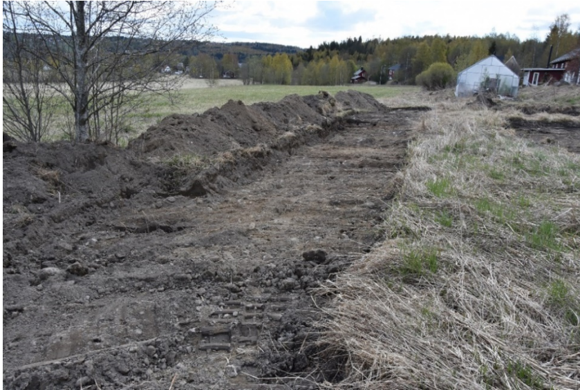
Figur 16. Schakt 1, inga anläggningar eller fynd påträffades. I bortre delen av schaktet syns en svag förhöjning i bilden, där var berghäll precis under jordlagret. I övrigt bestod jordarten av grusig morän och småsten. Foto från V.
