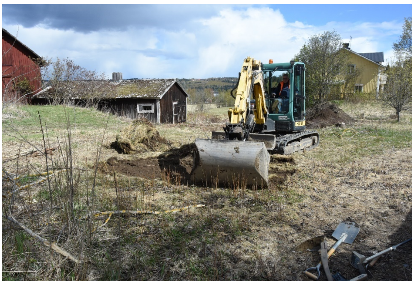
Figur 18. Schakt 6 påbörjat. Foto från V.
