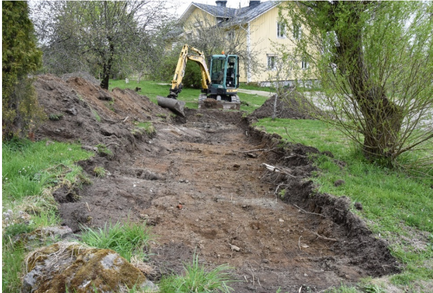
Figur 19. Schakt 8 i trädgården. Foto från S. Grusig och småsten, i bildens nederkant syns ett block och i mitten av schaktet var berg i dagen.
