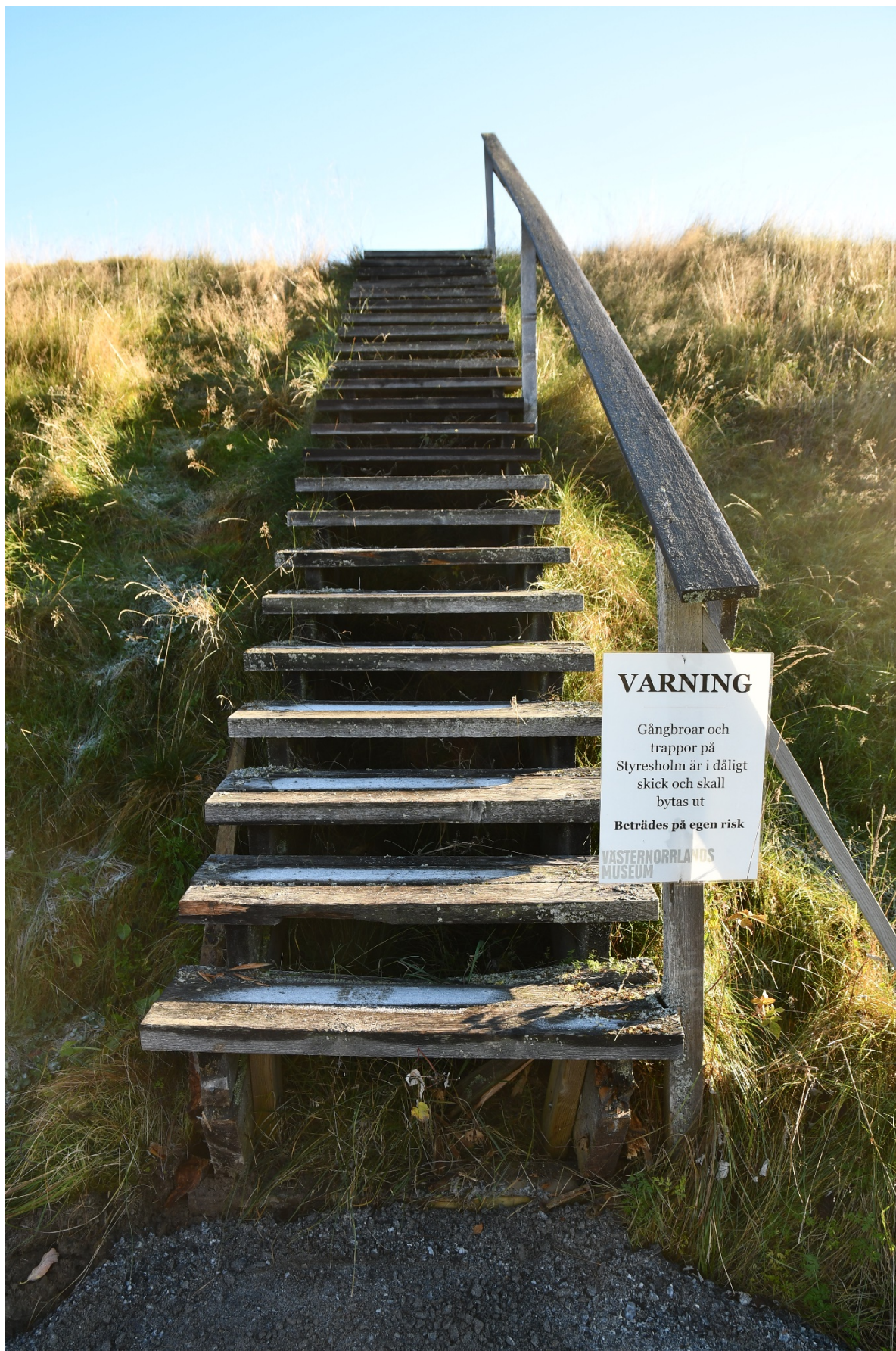
Figur 12. Trappor med varningsskylt. Foto från öster.
