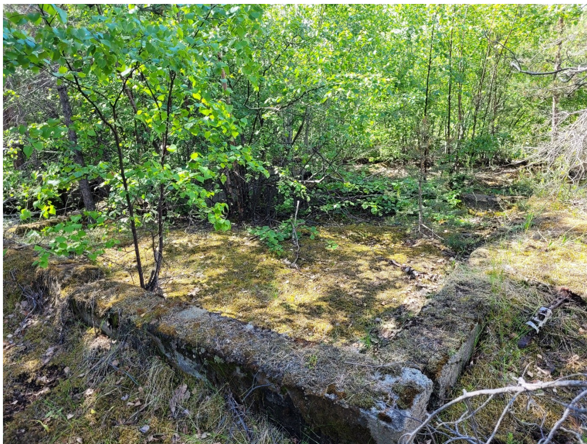
Figur 13. L2024:3147, husgrund i betong, inom område 52. Foto från öst.
