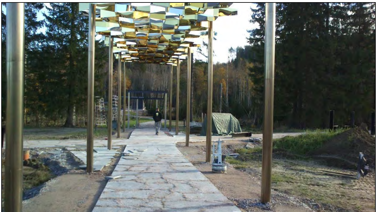
Fig. 45. Hösten 2014, bygget pågår.
