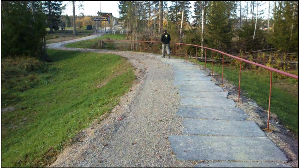
Fig. 44. Den färdiga stigen. Som blev bredare än planerat, vilket är en stor miss då inte undersökningen för stigen gjordes utifrån att flera meters bredd skulle tas i anspråk.
