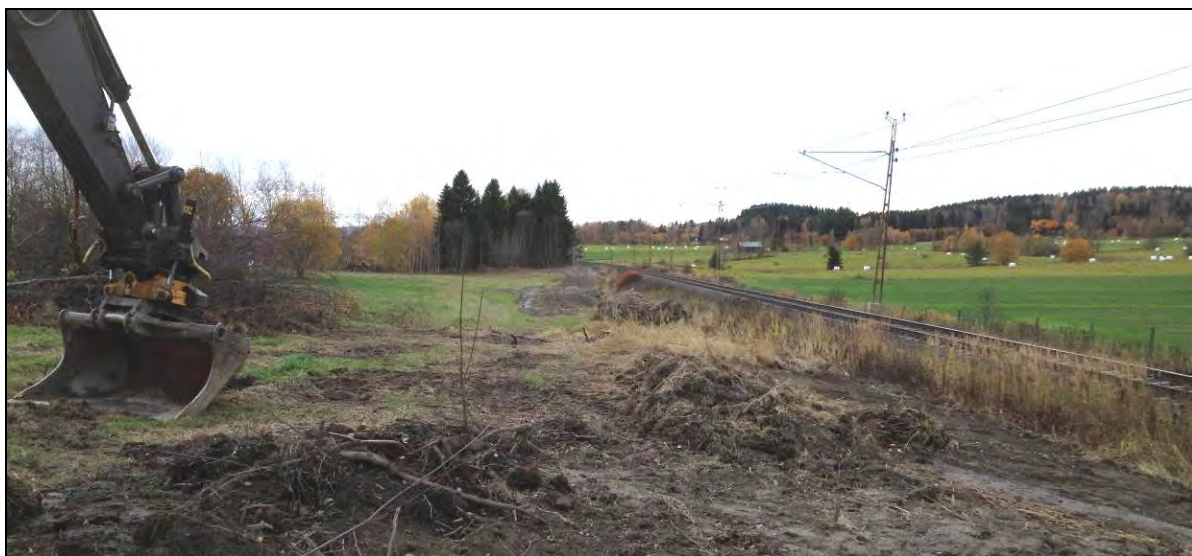
Delsträcka A, foto från öster. Redan påbörjad del av vägen syns längst bort vid tallarna och granarna mitt i bilden.
